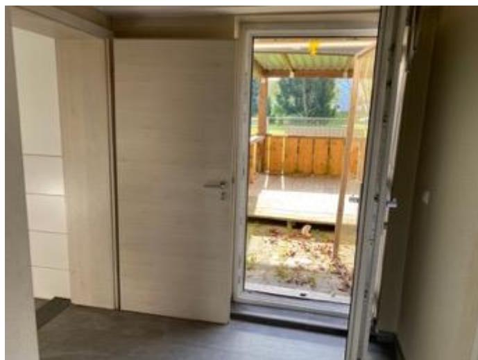
Zugang zur Terrasse (EG)
