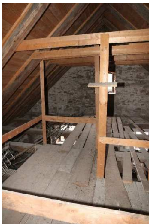
Wohnhaus – Dachboden Ebene 2
