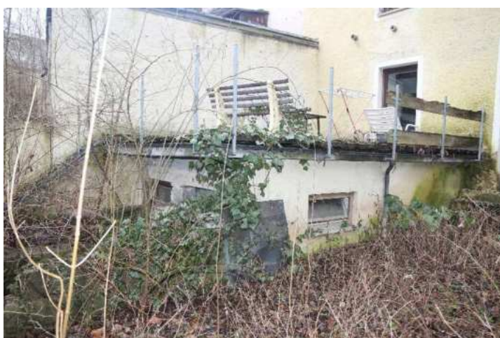
Anbau – Ansicht von Südosten
