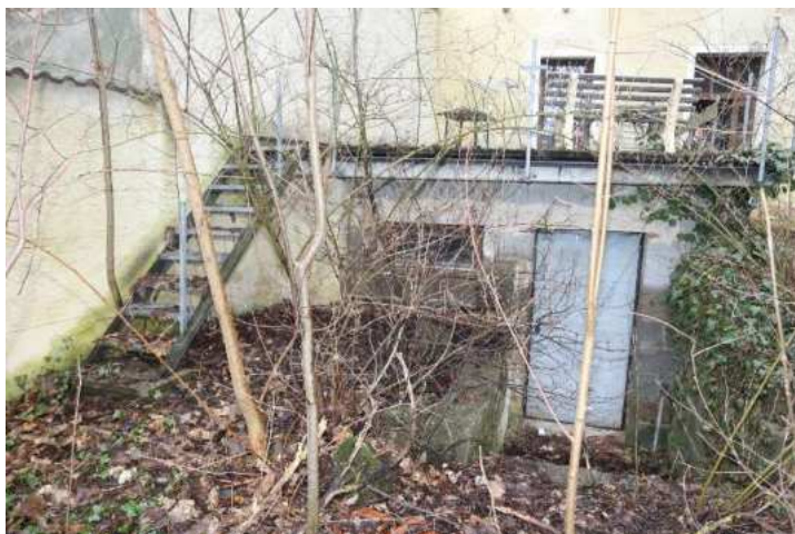
Anbau – Ansicht von Süden
