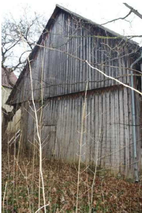
Scheune – Ansicht von Südwesten
