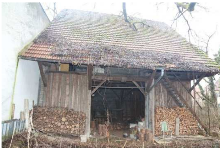
Scheune – Ansicht von Nordwesten
