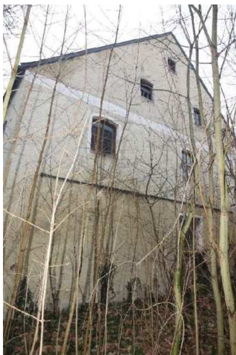
Wohnhaus - Ansicht von Osten
