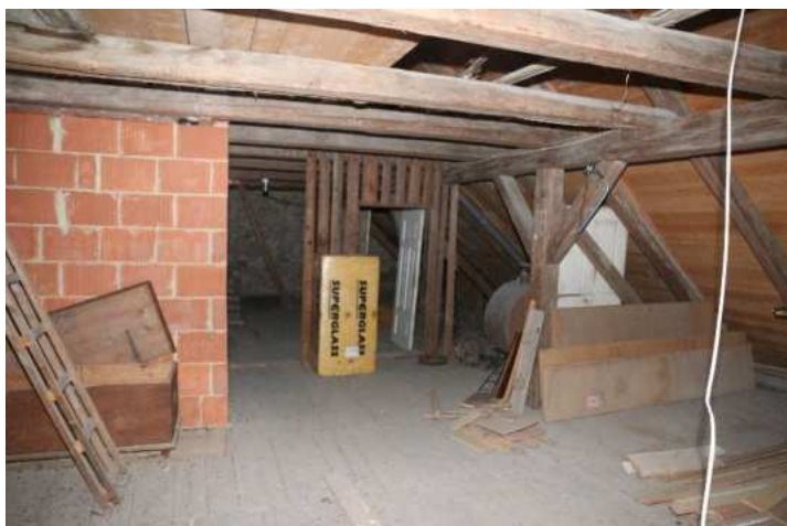
Wohnhaus – Dachboden Ebene 1
