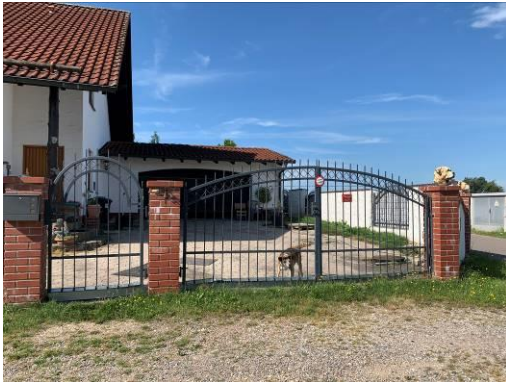
Zugang und Zufahrt an der Nord-Ostseite
