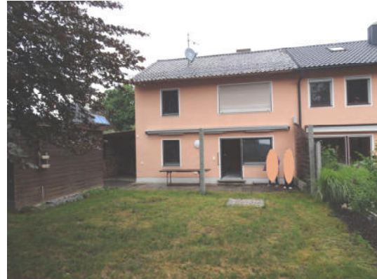
Südwestseite des Gebäudes
