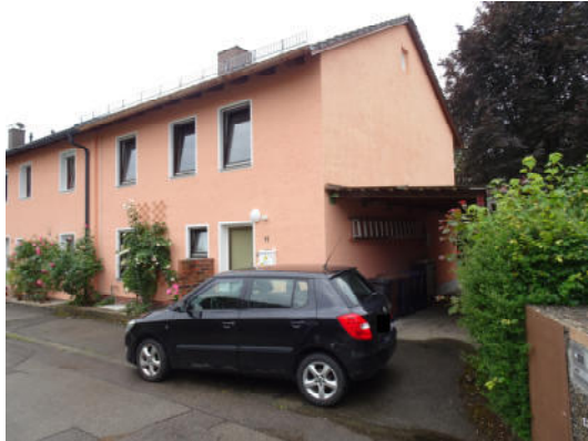
Nordostseite des Gebäudes
