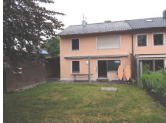
Südwestseite des Gebäudes
