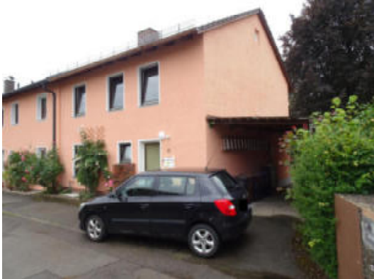
Nordostseite des Carports
