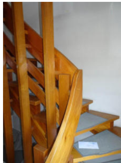
Treppe EG - OG
