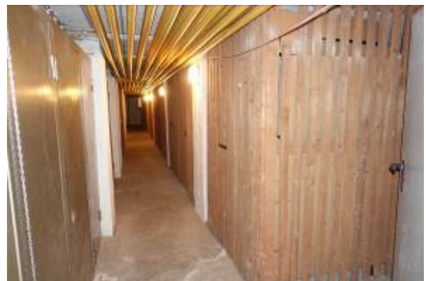
Kellerflur zu den Mieterkellern (KG)
