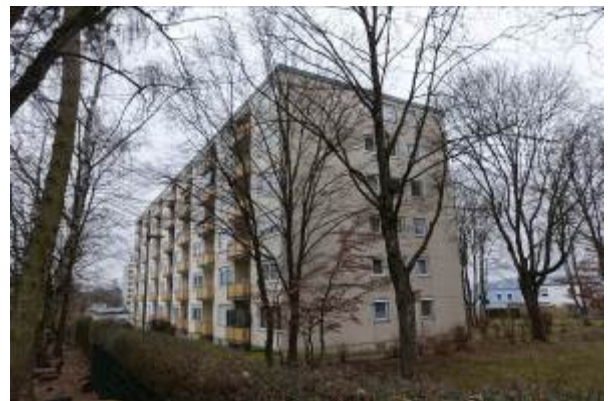
Südwestansicht des Gebäudes Robert-Koch-Straße 61
