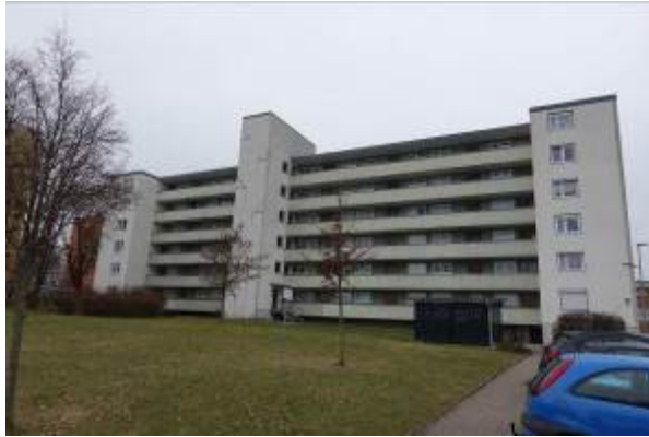
Nordostansicht des Gebäudes Robert-Koch-Straße 61
