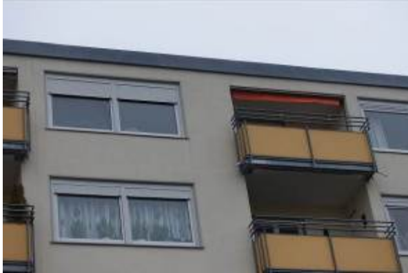
Westansicht der Wohnung Nr. 40 (5.OG)
