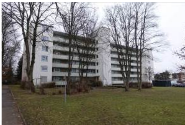
Südostansicht des Gebäudes Robert-Koch-Straße 61
