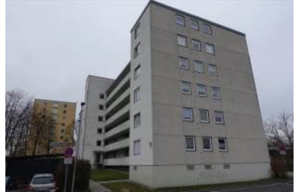
Nordostansicht des Gebäudes Robert-Koch-Straße 61
