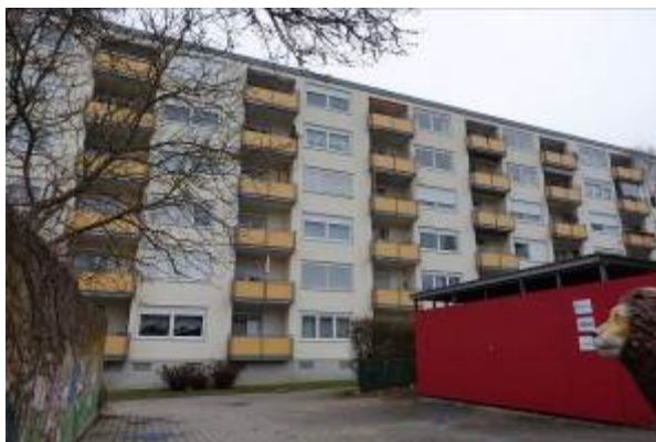
Nordwestansicht des Gebäudes Robert-Koch-Straße 61
