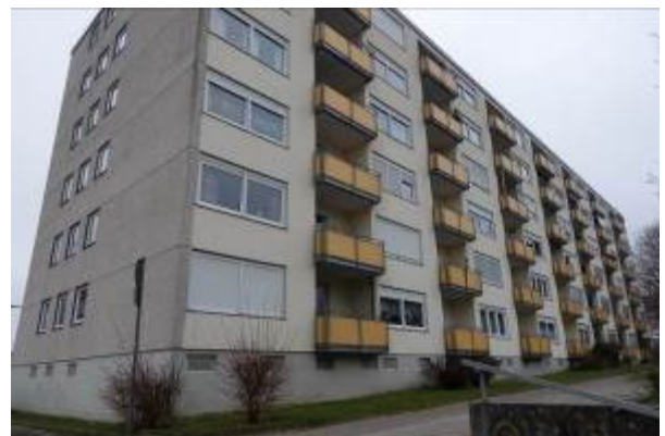
Nordwestansicht des Gebäudes Robert-Koch-Straße 61
