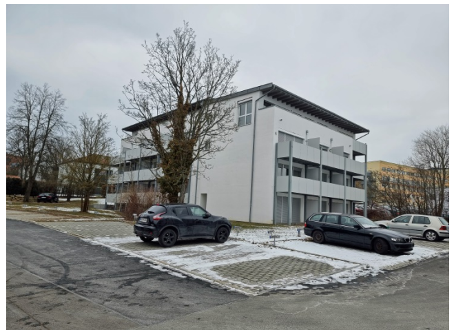
STPL 17 (= der Stellpl. mit dem Pkw) Ansicht von Südwesten
