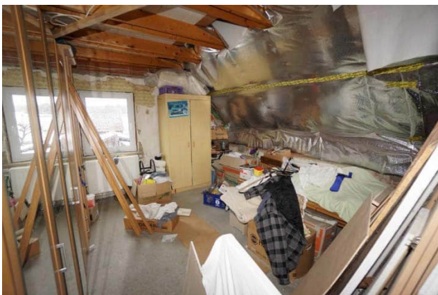
Wohnhaus Dachgeschoss (nicht ausgebaut) Raum 2
