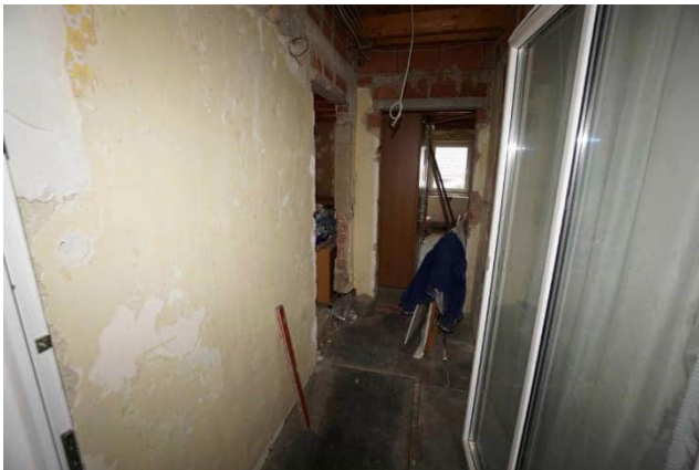
Wohnhaus Dachgeschoss (nicht ausgebaut) Flur
