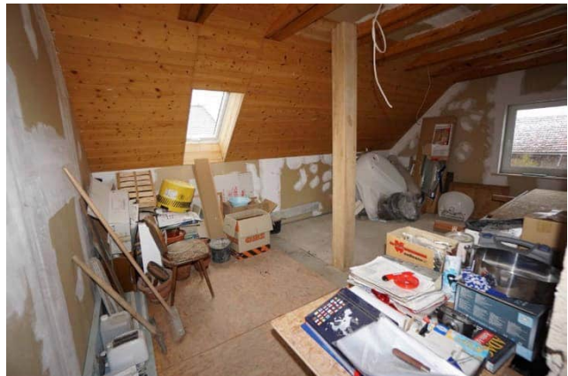
Wohnhaus Dachgeschoss (nicht ausgebaut) Raum 1
