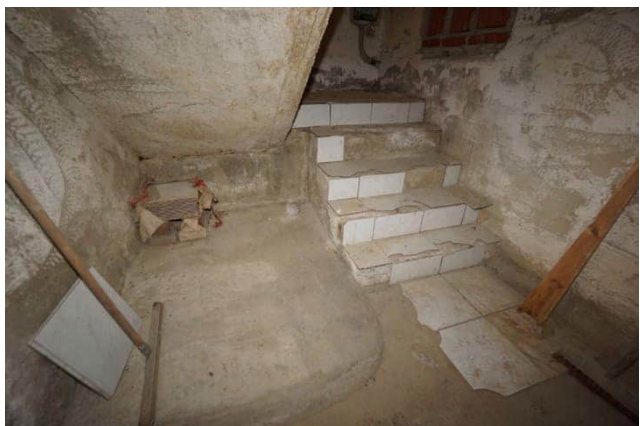
Wohnhaus Kellergeschoss Flur
