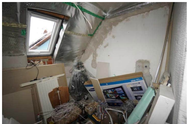
Wohnhaus Dachgeschoss (nicht ausgebaut) Bad
