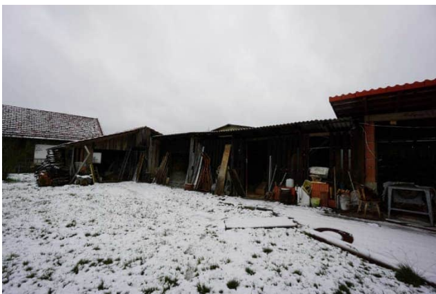
Außenanlagen Gebäude 3 + 4 Südostansicht
