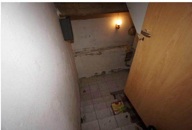
Wohnhaus Kellergeschoss Abgang
