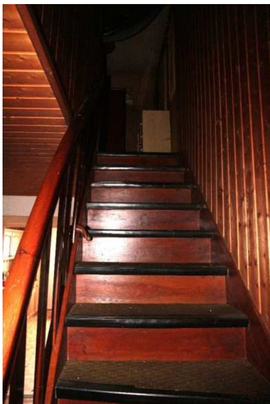
Treppe zum Dachraum
