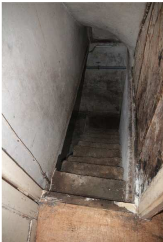
Treppe Keller- / Erdgeschoss
