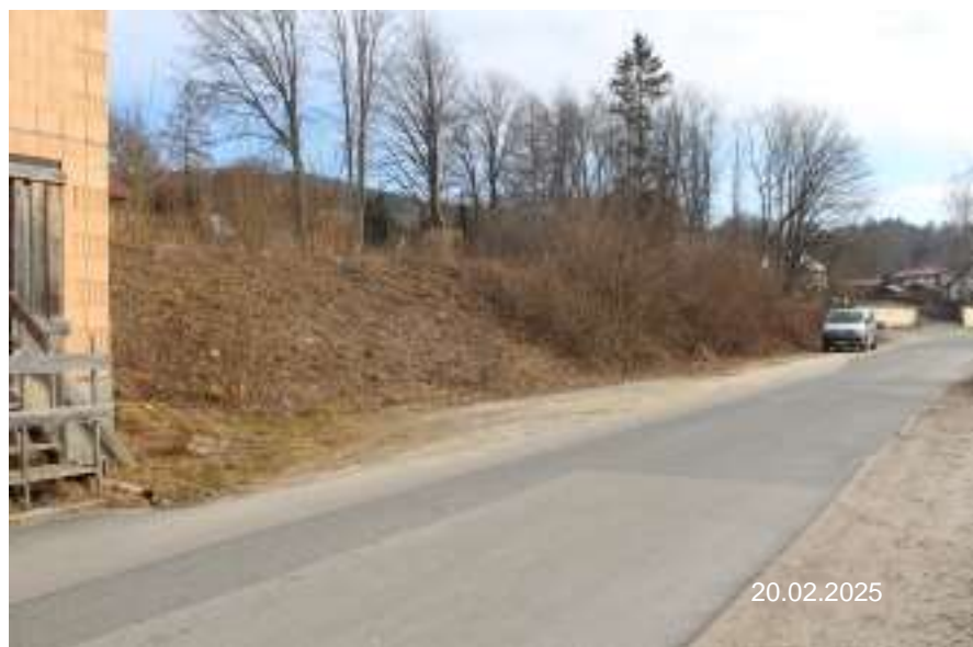
Bild 9: Ansicht östlicher Grundstückteil -Parken- von Westen
