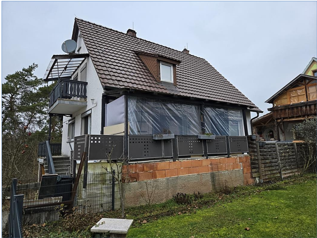
Bild 3 Pos. 01 Wohnhaus, Südostseite
