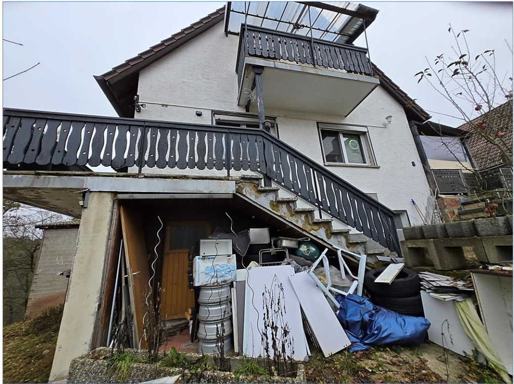
Bild 1 Pos. 01 Wohnhaus Südwestseite
