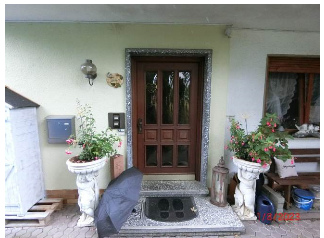
Hauseingang an der Nordostfassade
