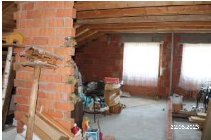
Bild 12: Dachboden - West- teil
