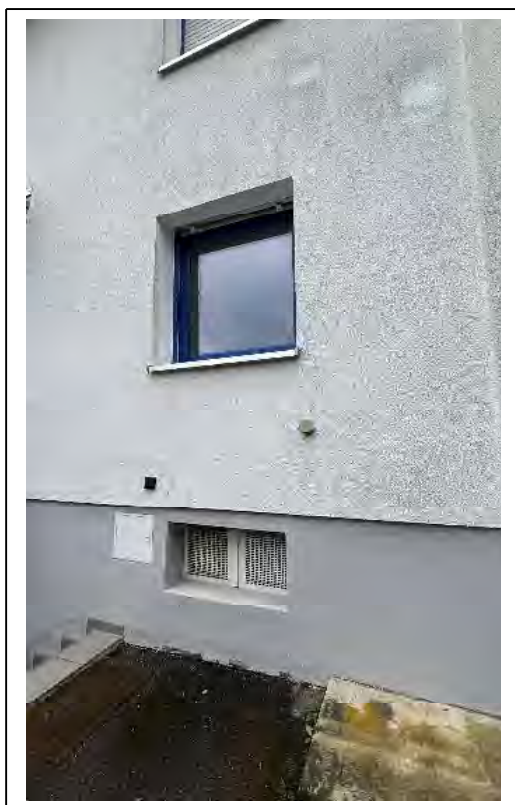
Foto 10: Wohnhausfassade mit WDVS
