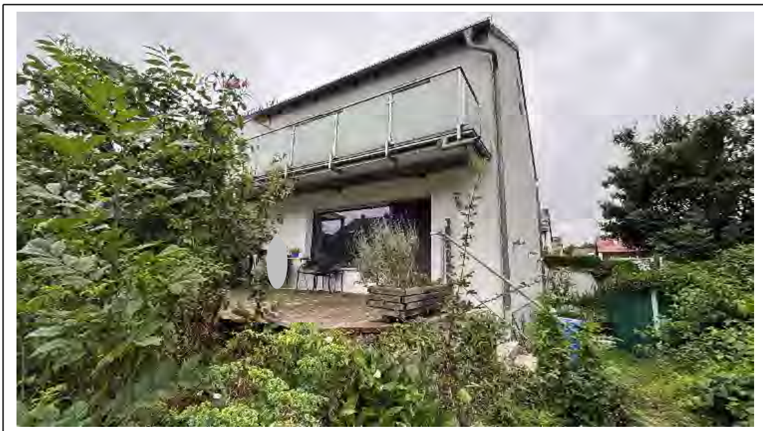
Foto 2: Ansicht von Südosten
