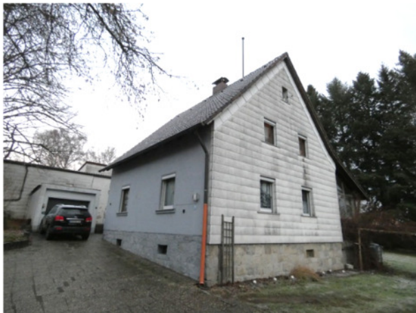
Wohnhaus Ansicht von Westen
