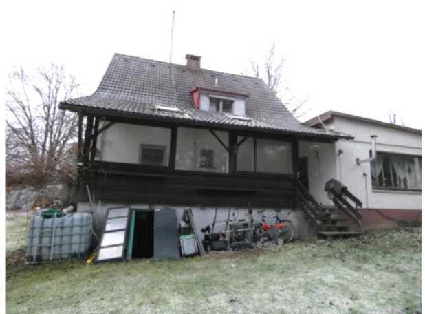
Wohnhaus Ansicht Rückseite
