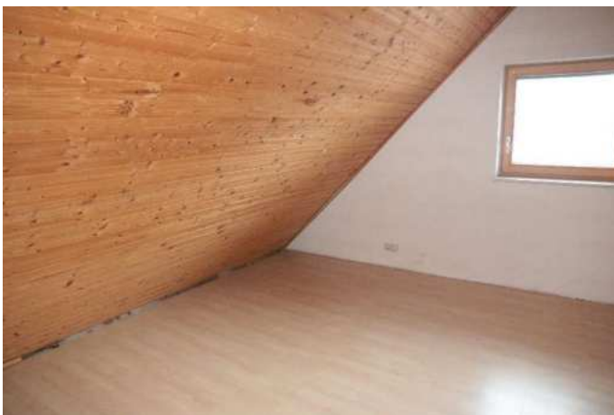
Dachboden – kleiner Wohnraum
