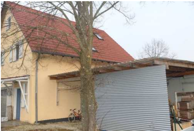
Ansicht von Südwesten mit Carport
