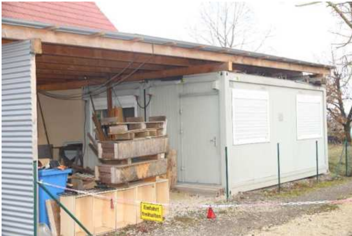
Carport mit Baucontainer
