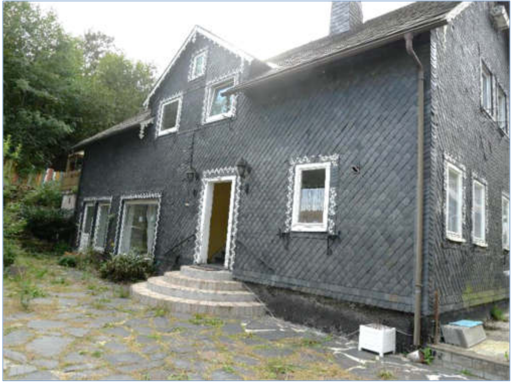
Bild 1 Pos. 01 Wohnhaus, Ostseite
