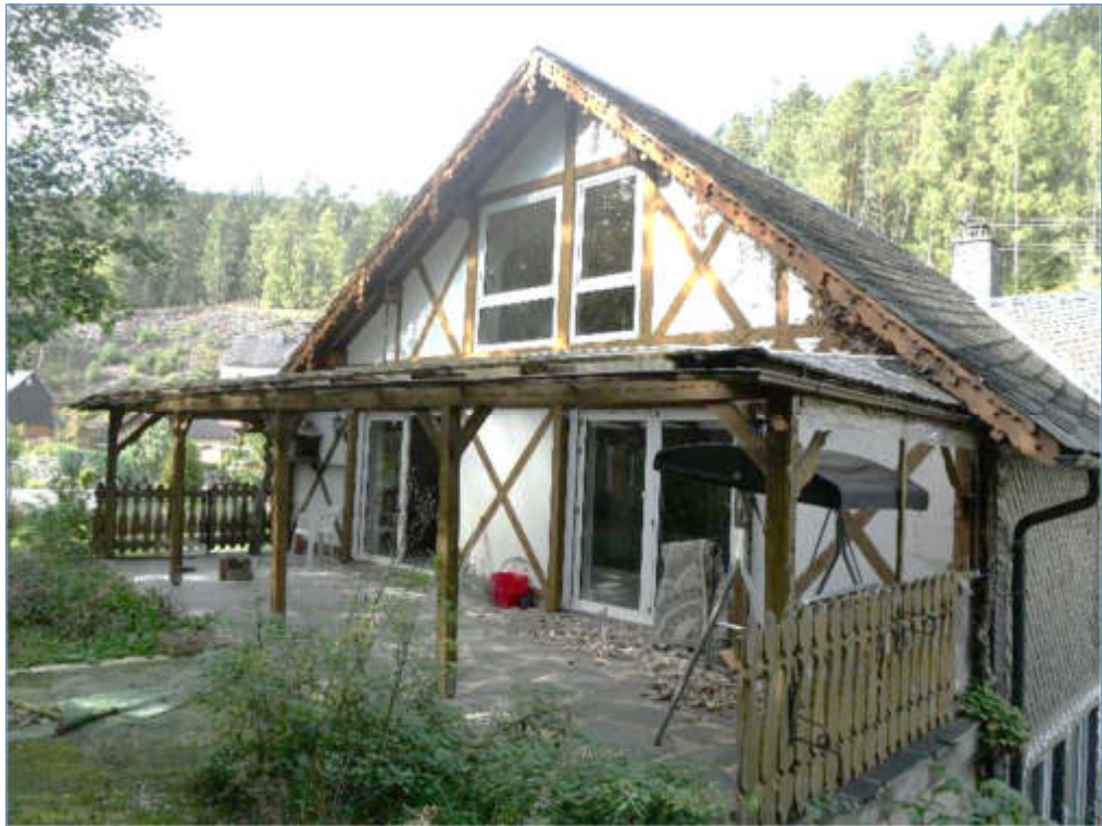
Bild 4 Pos. 01 Wohnhaus, Südseite
