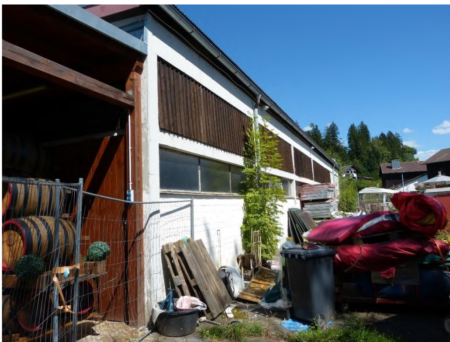
ehemalige Reithalle, Teilansicht von Südwesten
