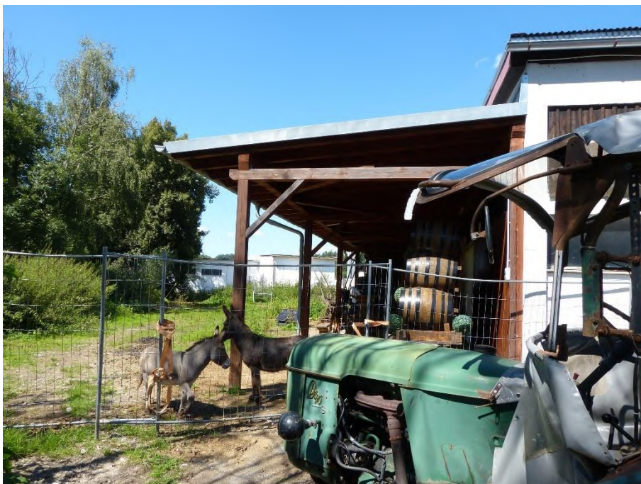
ehemalige Reithalle, Teilansicht Überdachung nach Westen
