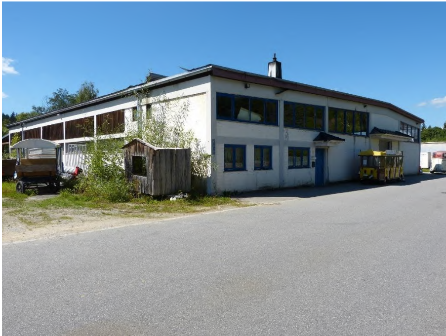
ehemalige Reithalle, Ansicht von Südosten
