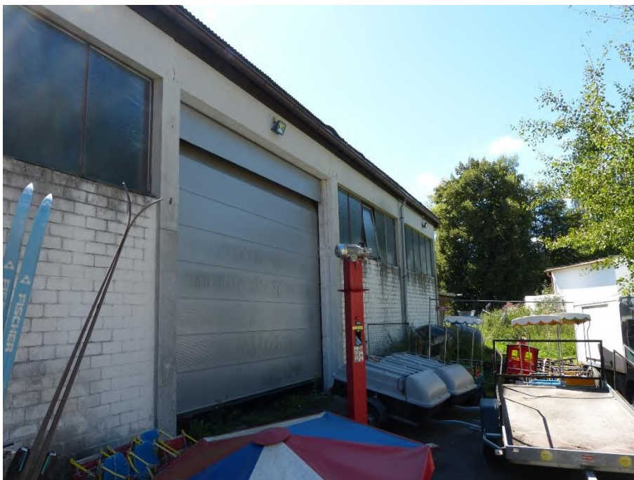
ehemalige Reithalle, Teilansicht von Nordosten
