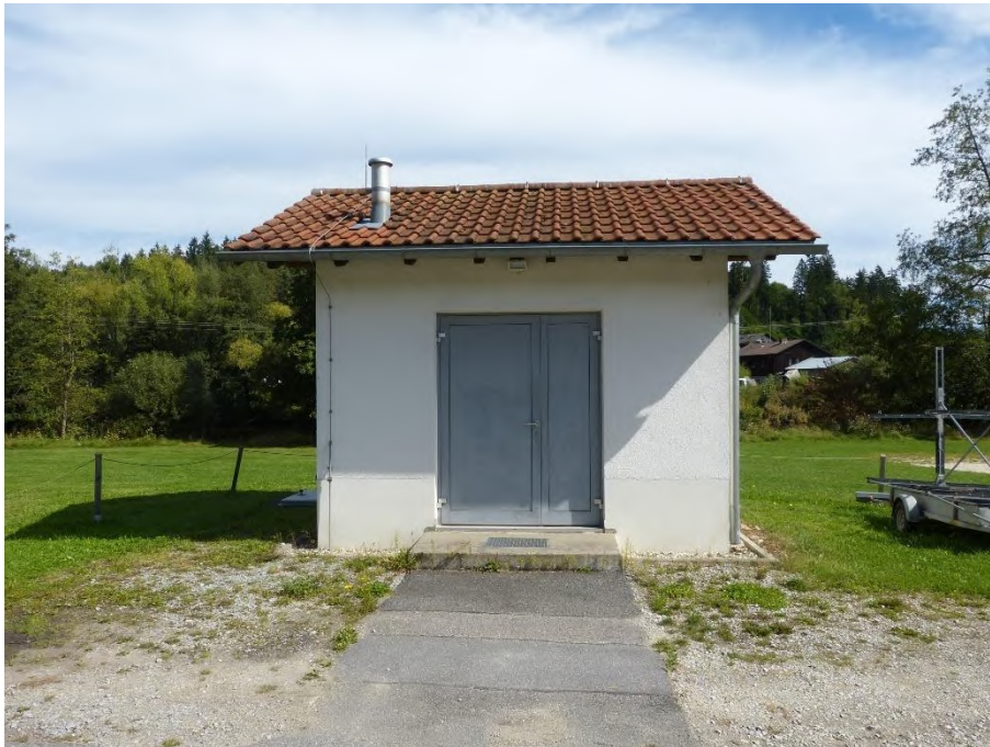
Freizeitfläche Flurstück 992, Pumpstation der Stadt Regen
