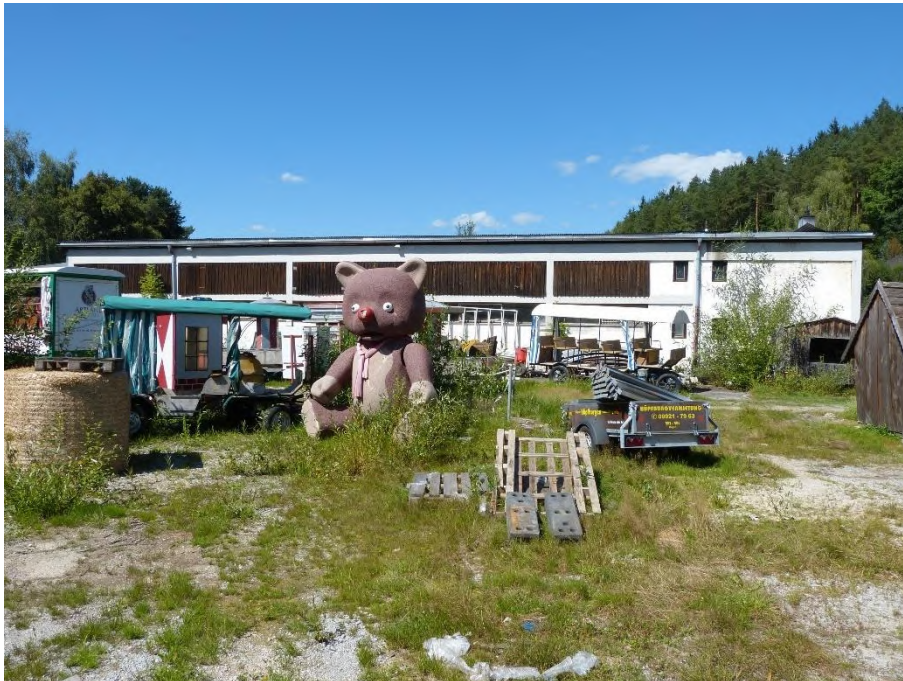
ehemalige Reithalle, Ansicht von Süden
