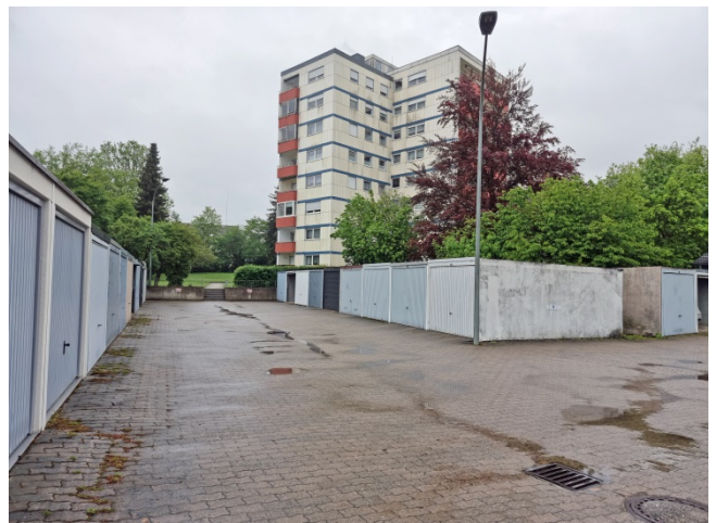
Garagenhof West 3. Garage v. re. auf Flst. 1976/7 Garage (Nr. 20)
