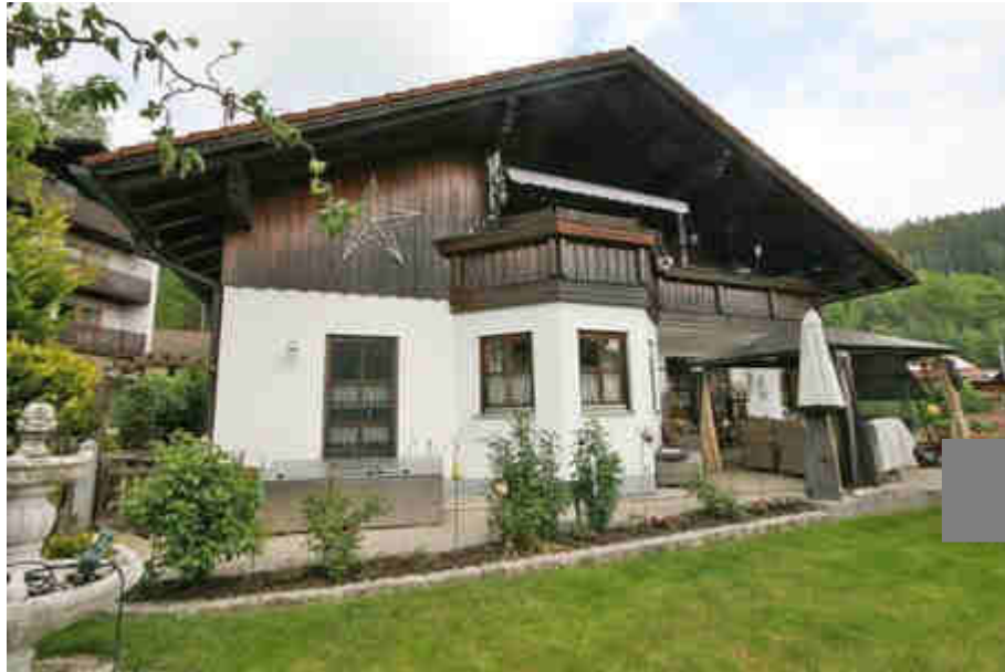
Blick auf Südostfassade des Wohngebäudes
