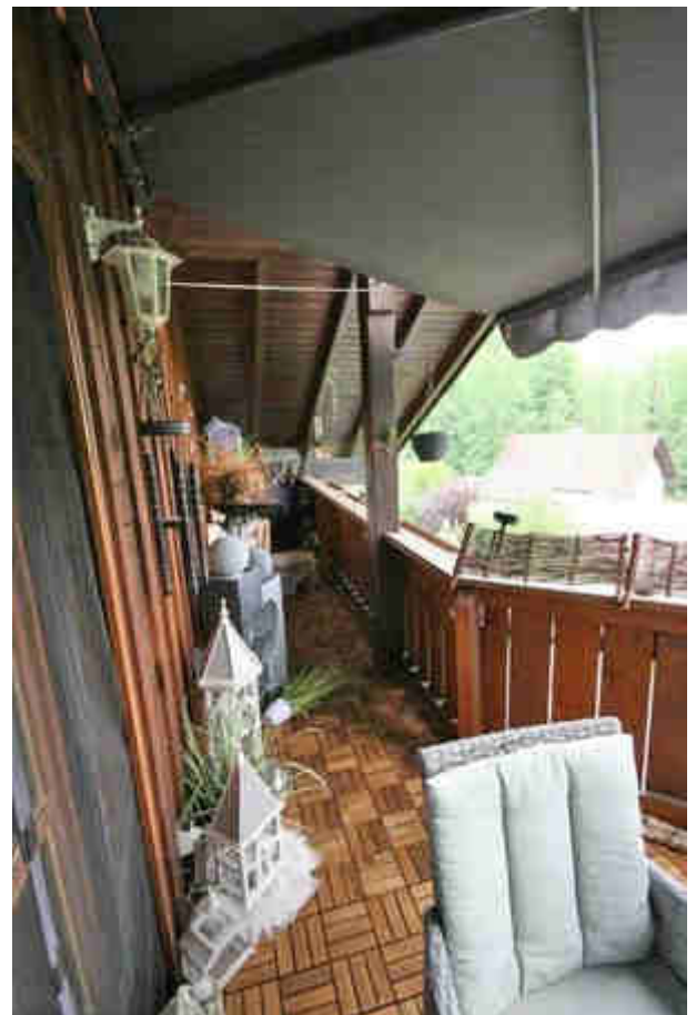
Blick auf überdachte Dachterrasse bzw. Balkon im DG
