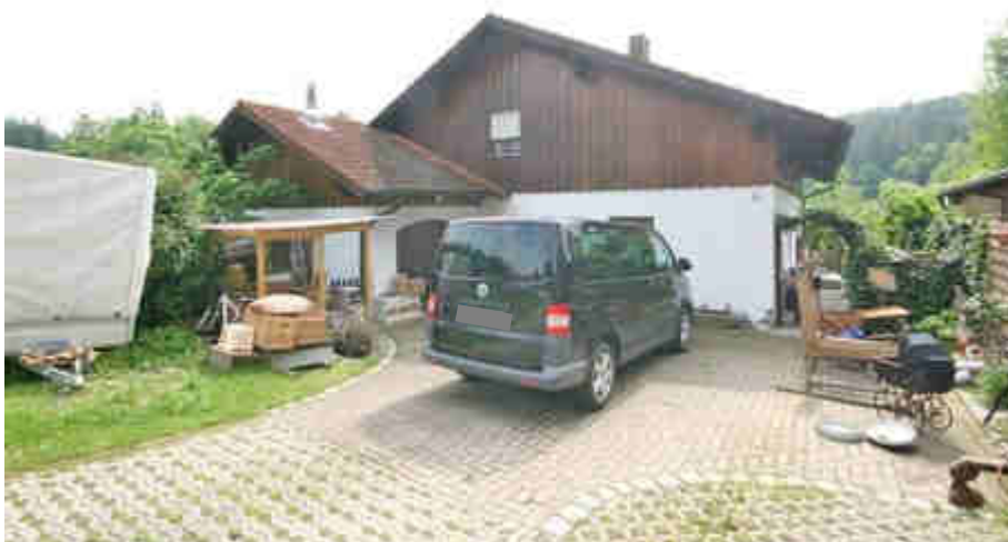
Blick von Nordwesten auf rechts im Bild Wohngebäude (Gebäude 1), links im Bild Garage (Gebäude 2)
