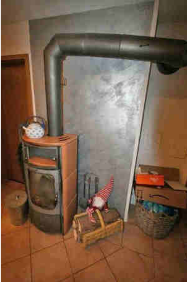
Blick auf Kaminofen im Flur im DG
