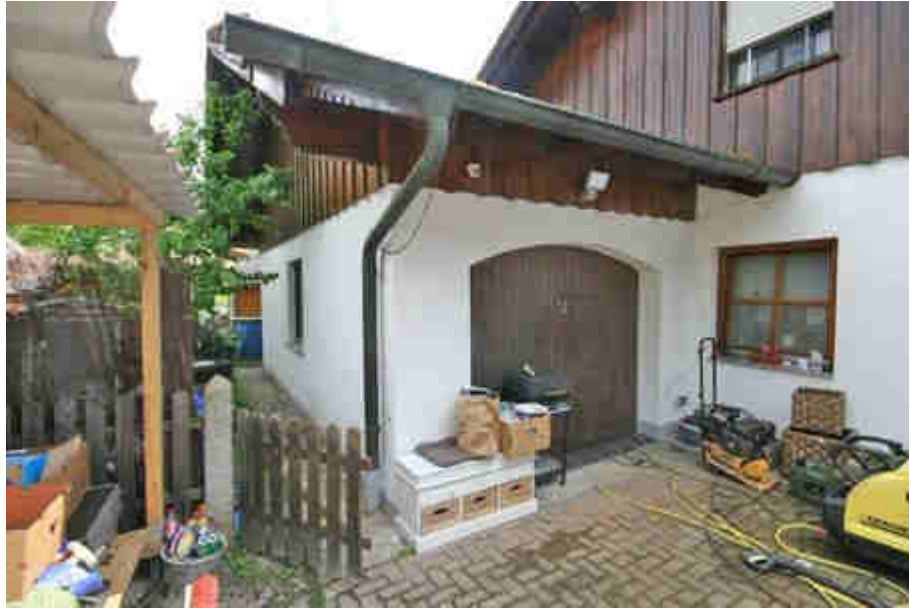
Blick auf angebaute Garage (Nutzung als Heizungsraum)
