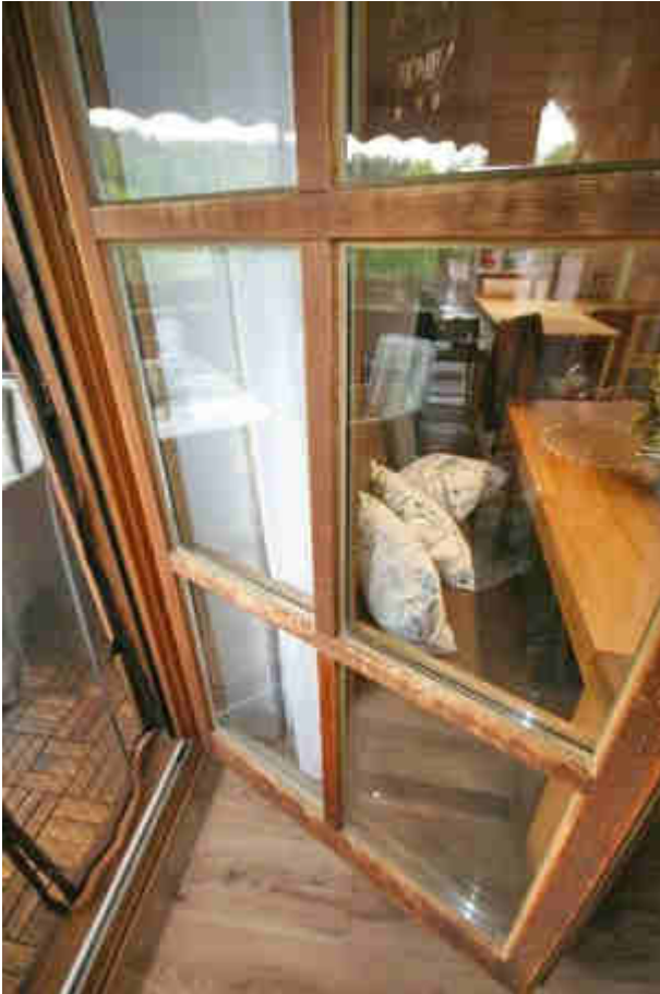
Blick auf Türblatt der Balkontüre im DG
