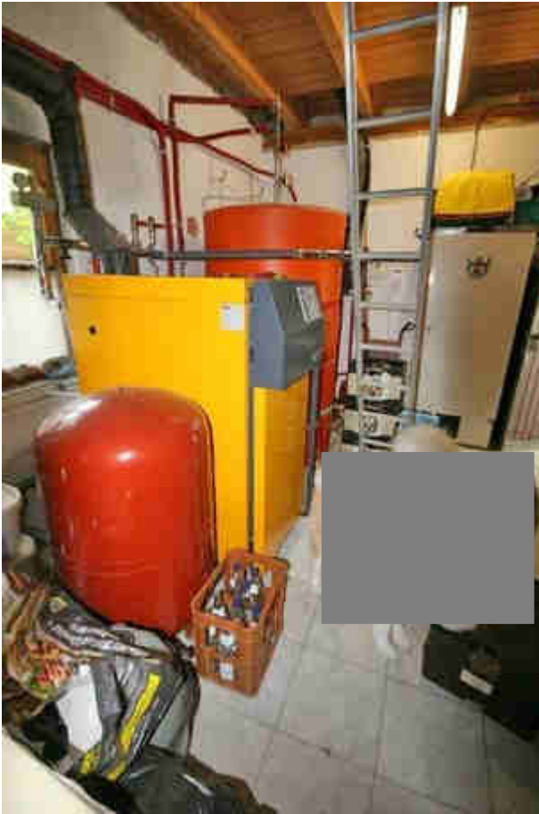
Blick auf Heizungsanlage mit Heizkessel für feste Brennstoffe (Scheitholz) und Warmwasserspeicher in der Garage
