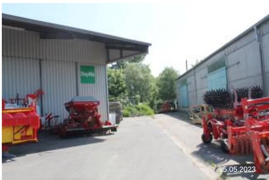
Bild 2: Fl.Nr. 1/76 Ansicht Zufahrt aus Westen – vom- BayWa - Baumarkt
