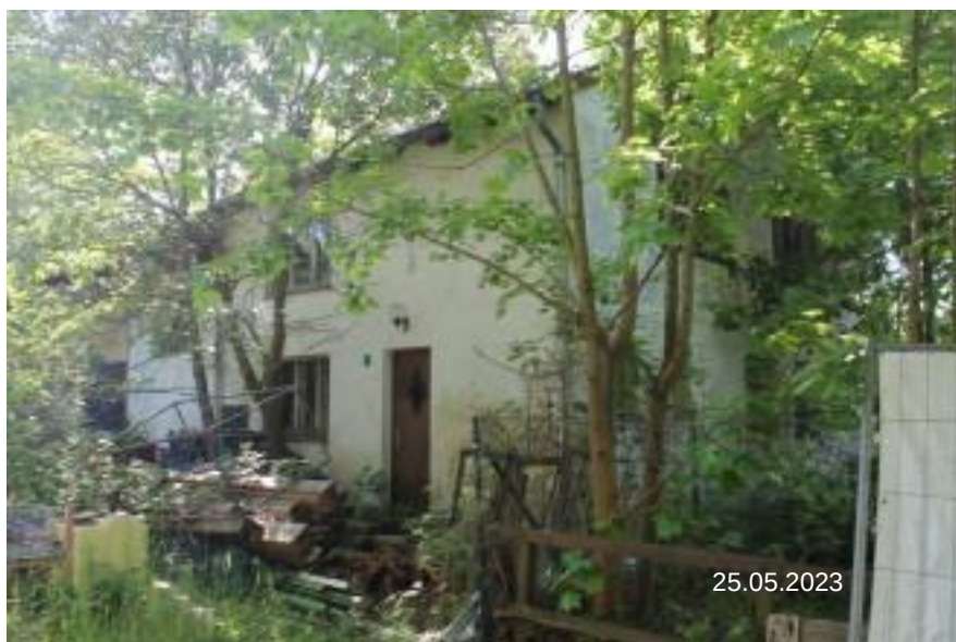
Bild 1: Fl.Nr. 1/76 Ansicht Wohnhaus + Halle 2 von Nord- westen
