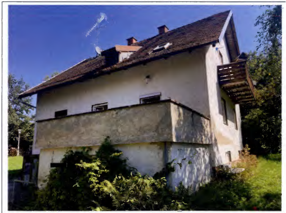
Foto 2: Ansicht von Südwesten
