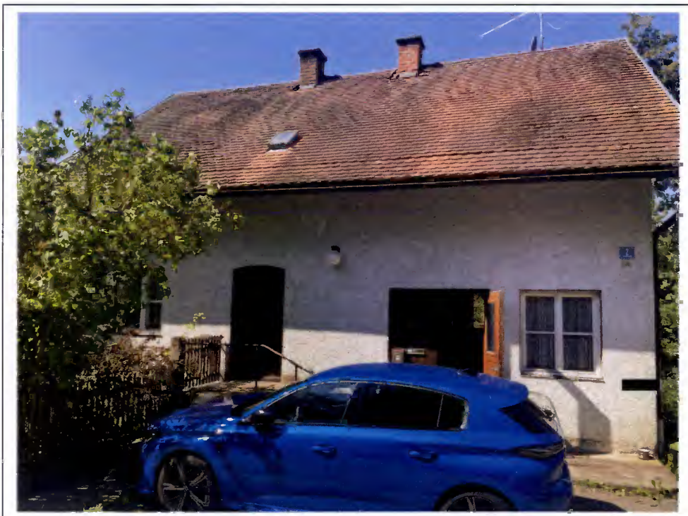
Foto 4: Ansicht von Osten
