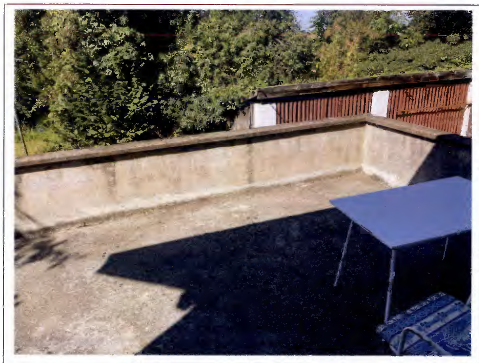
Foto 18: Blick auf die EG-Dachterasse
