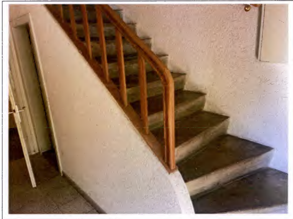
Foto 11: Treppe zum Dachgeschoss
