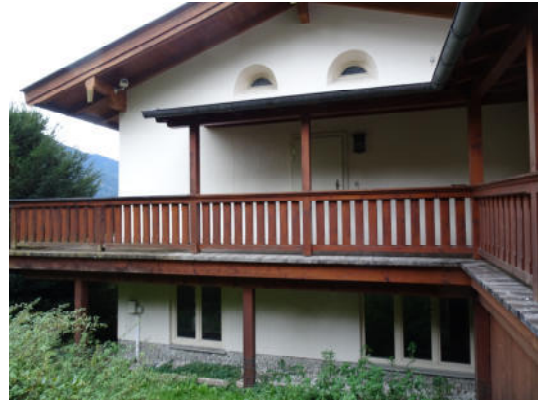
Nordostseite des Gebäudes
