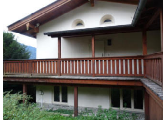
Nordostseite des Gebäudes
