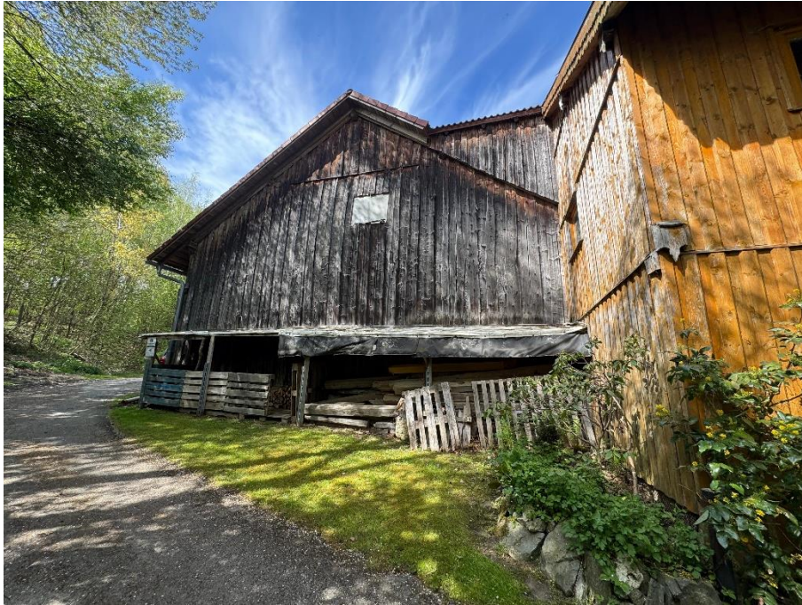
Gebäude 2: ehem. Stall und Scheune, Ansicht von Süden
