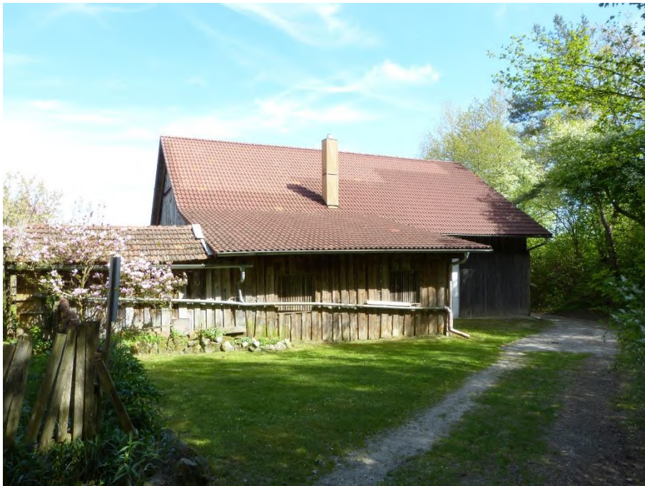
Gebäude 2 und 3: ehem. Stall und Scheune mit Schuppenanbau, Ansicht von Westen
