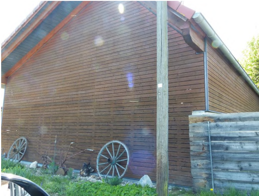
Gebäude 4: Nebengebäude, Teilansicht von Nordosten mit Überbau
