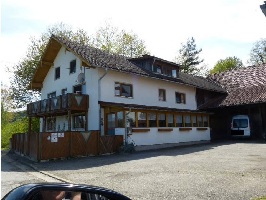
Gebäude 1: Einfamilienhaus (ehem. Bauernhaus), Ansicht von Nordosten
