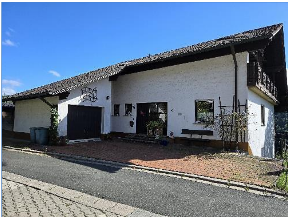
Bild 1 Pos. 01 Wohn / Geschäftshaus und BBT Garage, Nordwestseite
