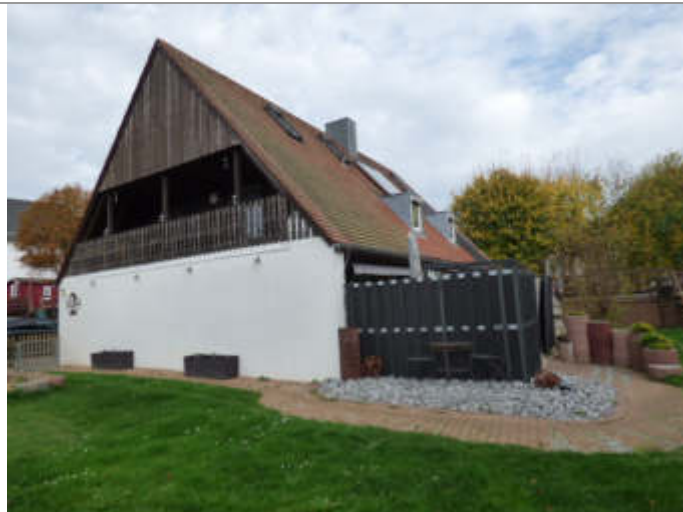
Gesamtaußenansicht von Südwesten
