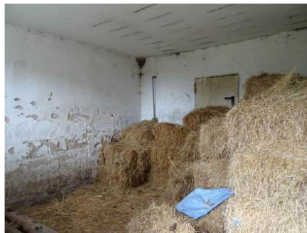
Heulager mit Tür zum Öltankraum
