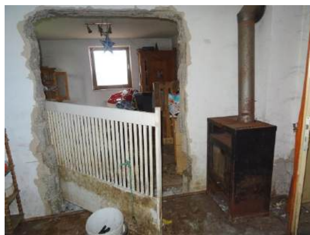
OG/ Wohnen/ Durchbruch zum Zimmer 2
