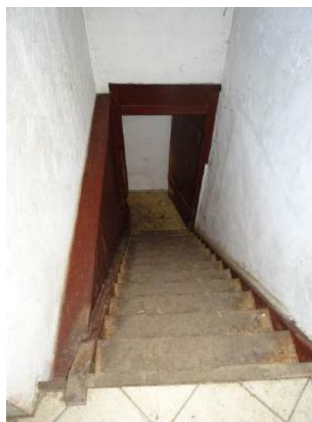
OG/ Treppe zum DG
