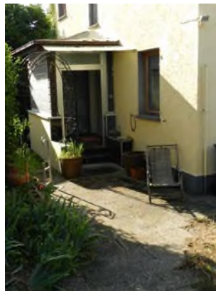
Hauseingang bei Nordfassade
