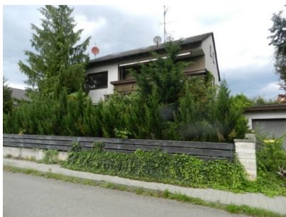
Ansicht von der Straße Am Nußgraben, von Süden
