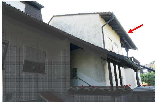
Blick von Westen auf das Bewertungsobjekt (rechte Bildseite)
