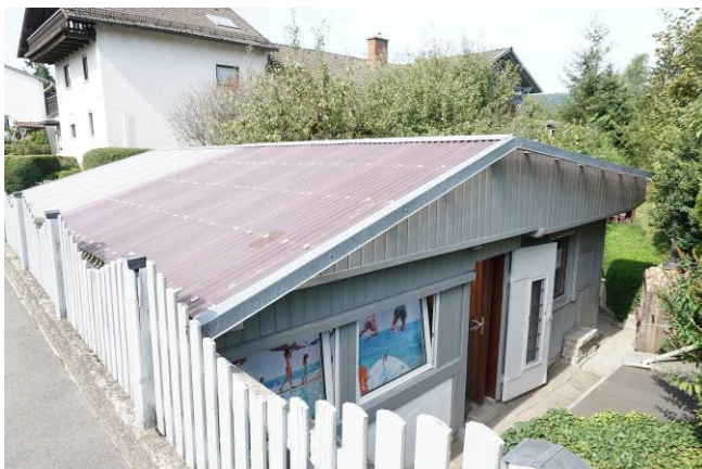
Gartenhaus an der östlichen Grundstücksgrenze
