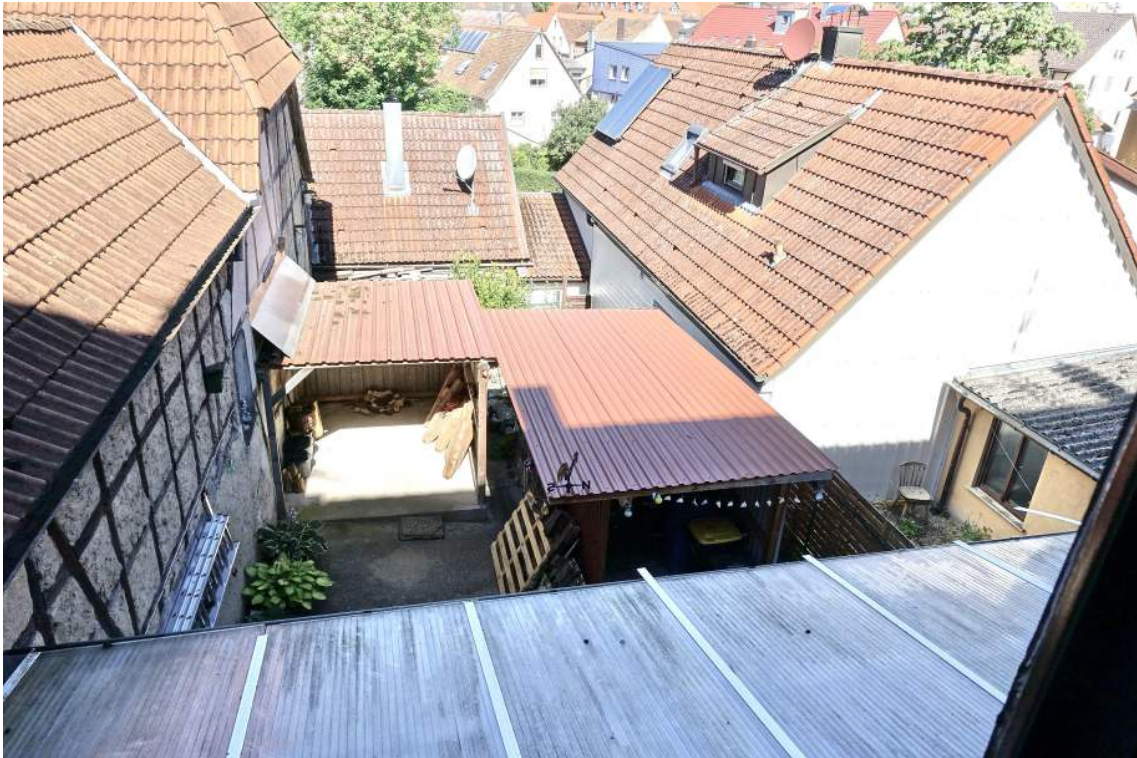
Blick vom Obergeschoss nach Norden über den kleinen Hof
