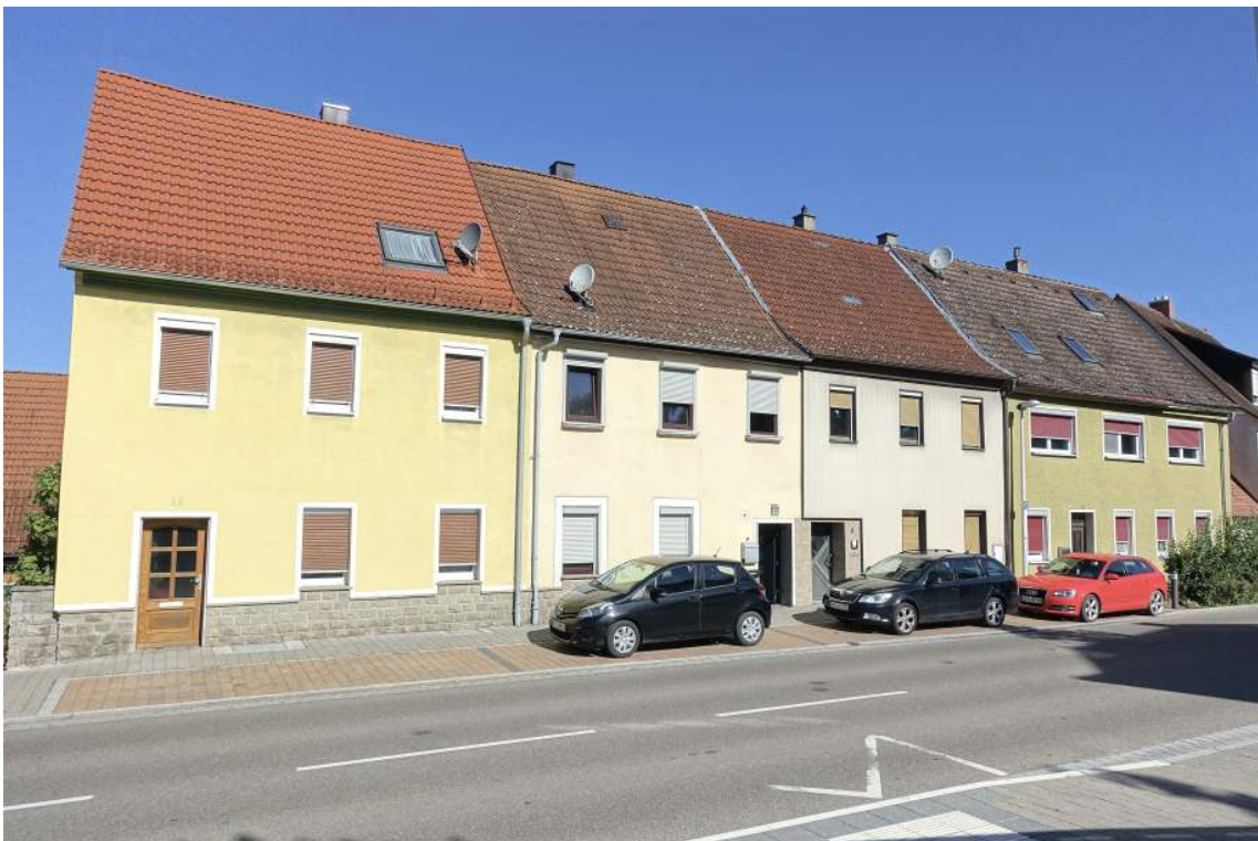
Ansicht von Nordosten, die Haus Nr. 10 ist das zweite Gebäude von links
