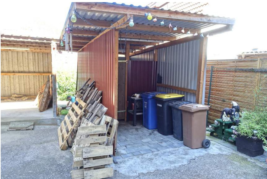
offener Schuppen im kleinen Hof an der Nordseite
