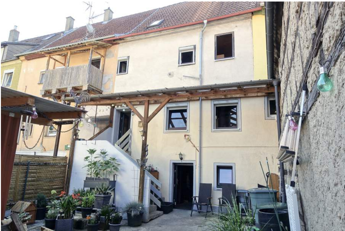
Ansicht von Westen vom Hof
