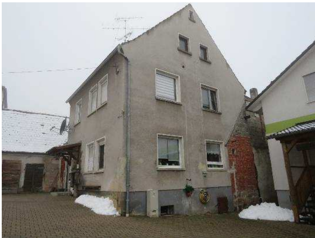
Abbildung: Ansicht von Osten
