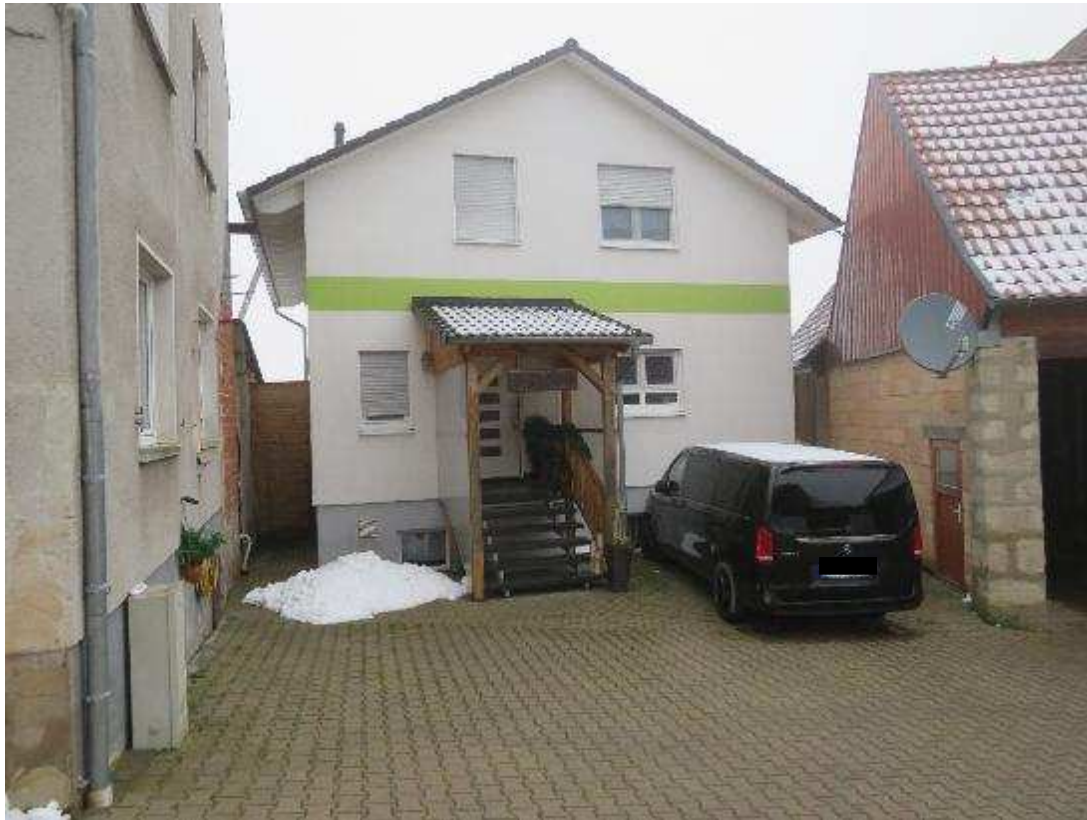
Abbildung: Ansicht von Südosten (Fahrzeugkennzeichen unkenntlich gemacht)
