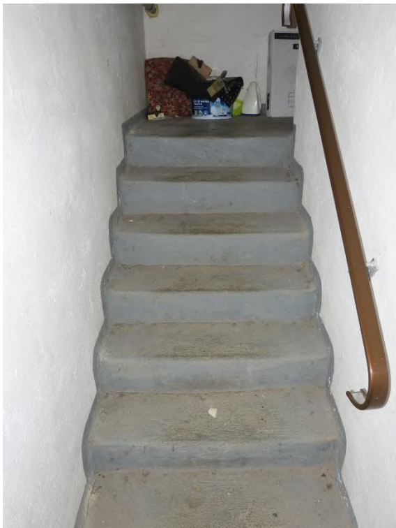
Zweifamilienhaus, Innenaufnahme Treppe vom Keller- zum Erdgeschoss
