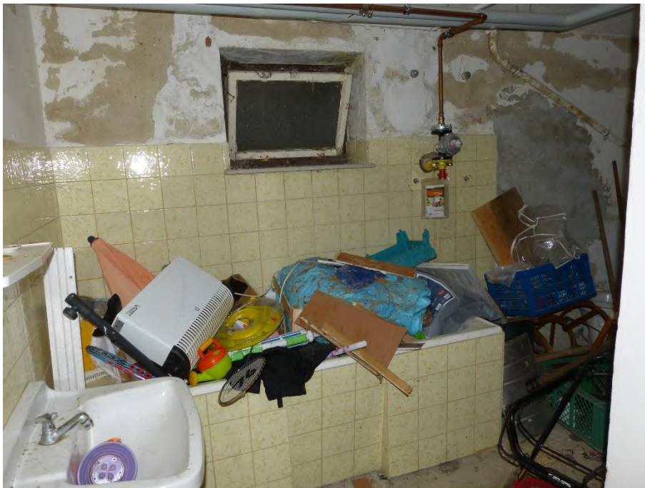
Zweifamilienhaus, Innenaufnahme ehemaliges Bad im Kellergeschoss
