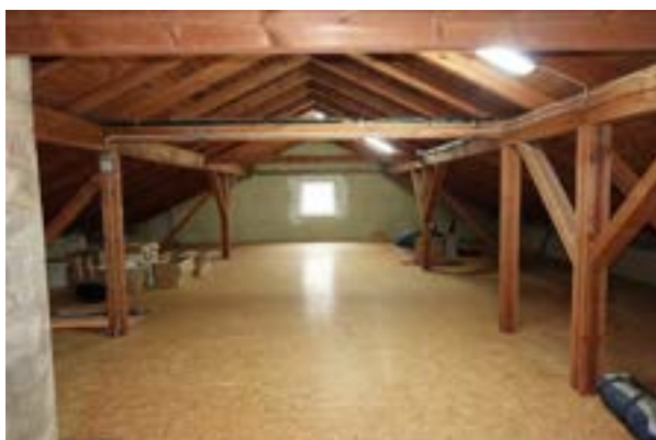
Nicht ausgebautes Dachgeschoss
