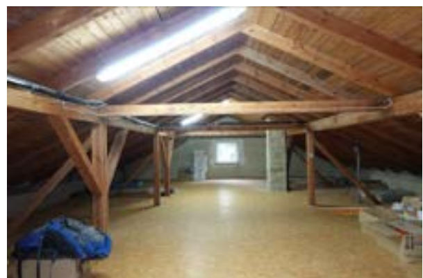
Nicht ausgebautes Dachgeschoss
