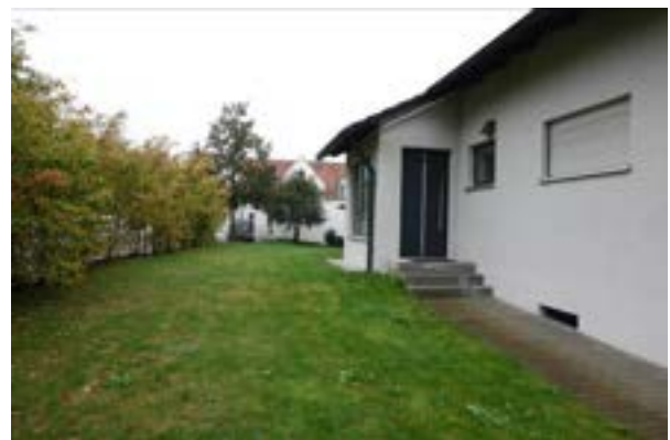
Einfamilienhaus, Blick aus nordwestlicher Richtung
