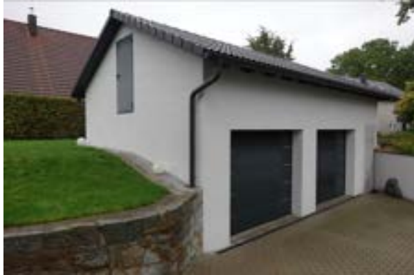
Doppelgarage, Blick aus nordöstlicher Richtung
