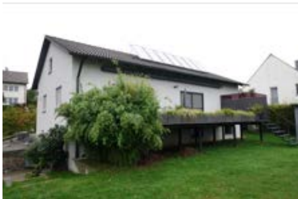
Einfamilienhaus, Blick aus südwestlicher Richtung
