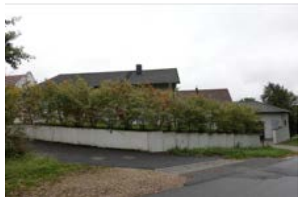
Bewertungsobjekt, Blick aus nördlicher Richtung
