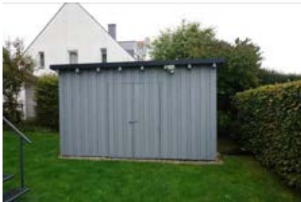
Gartengerätehaus, Blick aus nordwestlicher Richtung
