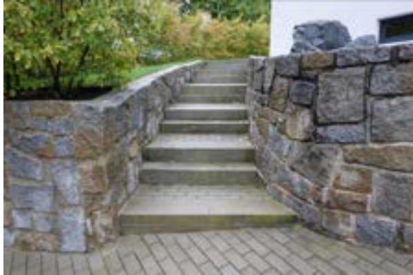
Zugang zum Hauseingang
