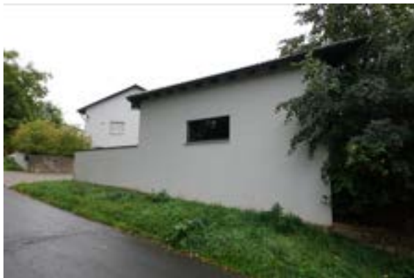
Doppelgarage, Blick aus südwestlicher Richtung
