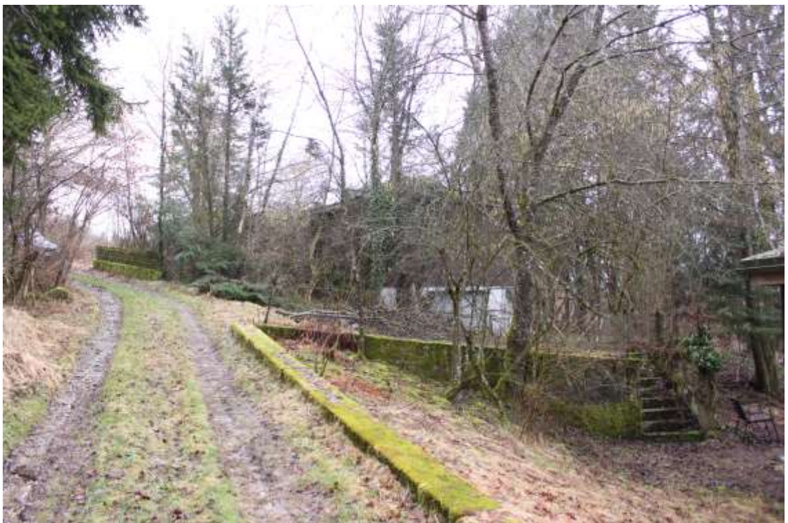
Bild 10: Zustand des privaten Erschließungsweges
