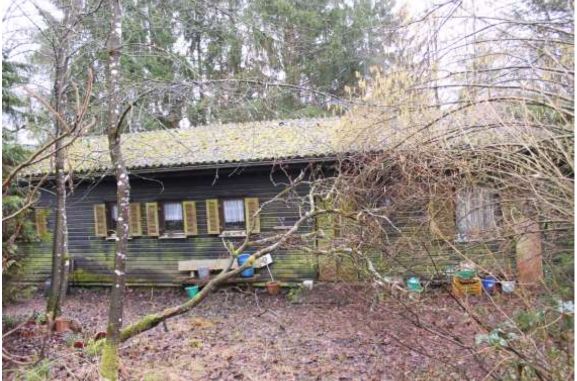
Bild 1: Ansicht von Norden
