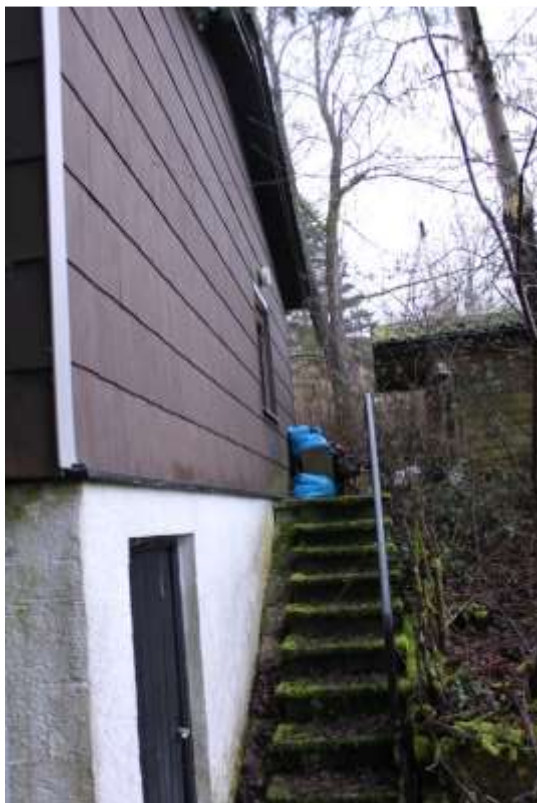
Bild 2: Ostfassade mit Außentreppe zum Keller
