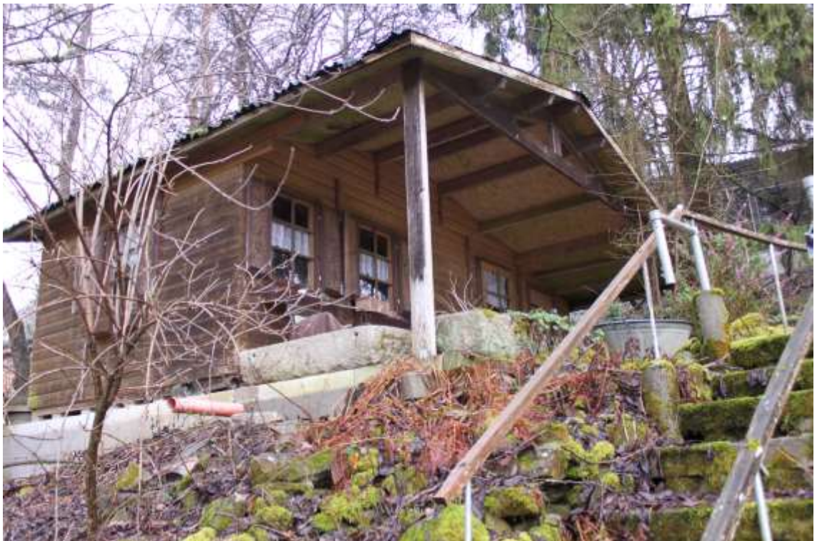
Bild 8: zu beseitigendes Gartenhaus 1 von Süden
