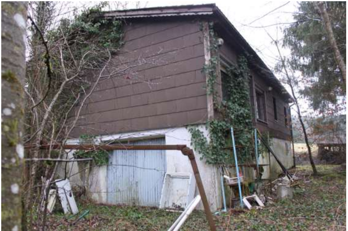
Bild 3: Ansicht von Südwesten
