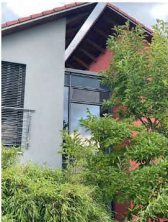
Teilbereich der Westfassade
