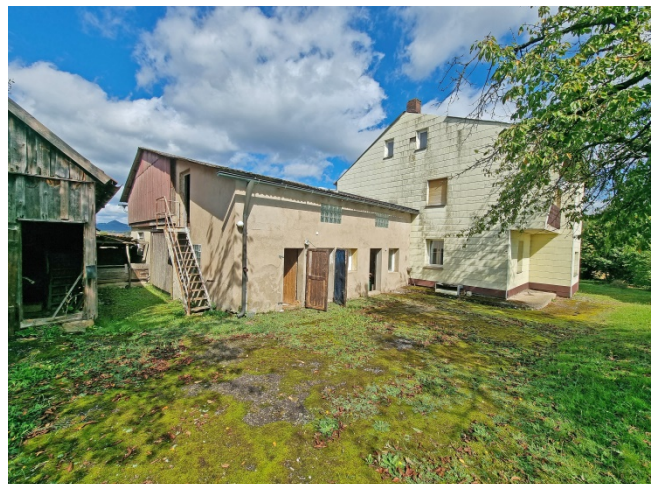
Scheune LKW-Halle Wohnhaus Ansicht von Süden (vom Garten aus)
