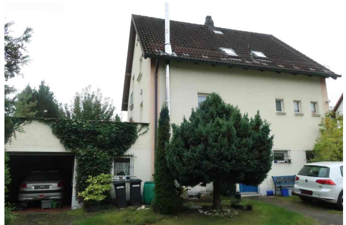
Ansicht von Nord-Ost. Garageneinfahrt
