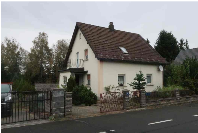
Ansicht von Süd-West. Zufahrt
