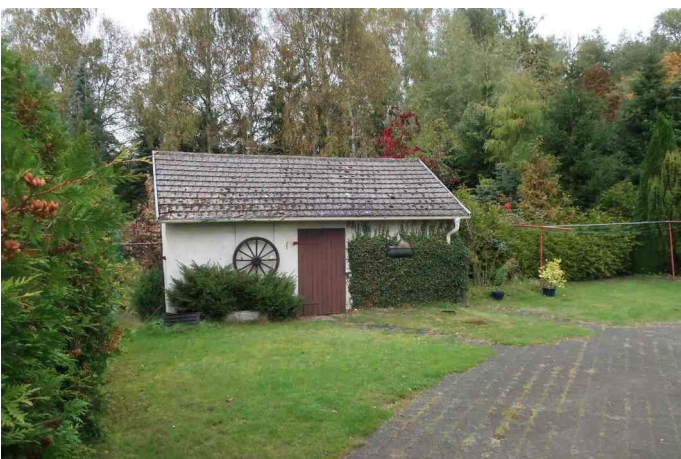
rückwärtiges kl. Nebengebäude
