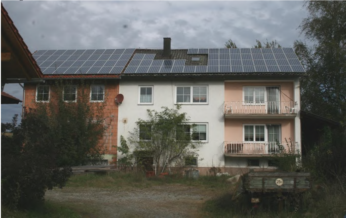
Bild 5: Standort auf der Gemeindeverbindungsstraße, die unmittelbar südlich am Hofstelenanwesen entlang verläuft, im Bereich der Hofeinfahrt, Blickrichtung Norden. Im Bild die Südseite des viergeschossigen Wohnhauses, dessen Untergeschoss an der Nordseite in den Hang gebaut ist. Im rechten Bildteil der ungefähr 1964 errichtete Altbauteil (Ostteil), der ca. \frac{2}{3} der Gebäudegrundfläche einnimmt, und im linken Bildteil der ca. 2008 erbaute Neubauteil (Westteil), auf den etwa \frac{1}{3} der Gebäudegrundfläche entfallen.
