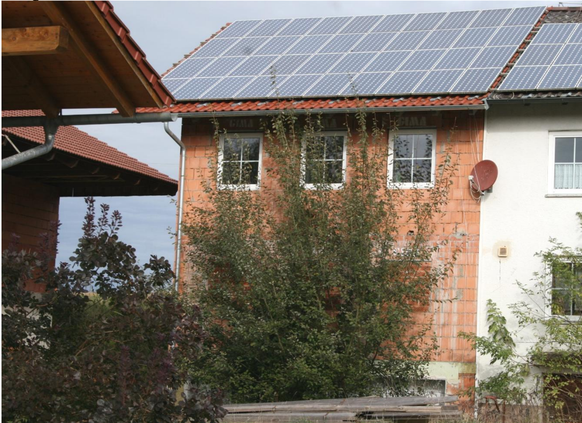
Bild 7: Standort auf der Gemeindeverbindungsstraße, die unmittelbar südlich am Hofstellenanwesen entlang verläuft, im Bereich der Hofeinfahrt, Blickrichtung Nordnordwest. Im Bild die Südseite des viergeschossigen Wohnhauses, hier der ca. 2008 errichtete Neubauteil (Westteil). Hier sind im Bereich des Erdgeschoss zwar die Fensteröffnungen vorhanden, es fehlen aber die Fenster an der Südseite im Erdgeschoss. Dem äußeren Anschein nach befindet sich zumindest das Unter- und Erdgeschoss vermutlich noch im Rohbauzustand.
