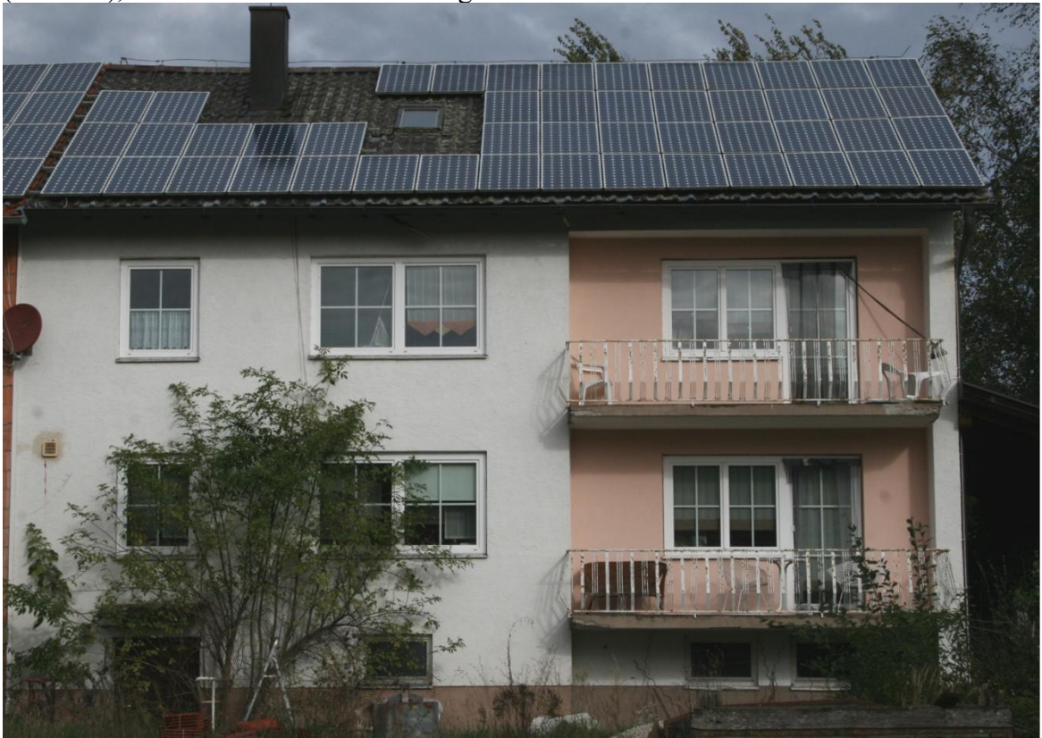
Bild 6: Standort auf der Gemeindeverbindungsstraße, die unmittelbar südlich am Hofstelenanwesen entlang verläuft, im Bereich der Hofeinfahrt, Blickrichtung Norden. Im Bild die Südseite des viergeschossigen Wohnhauses, hier der ca. 1964 errichtete Altbauteil (Ostteil) mit den teilweise vorgezogenen Balkonen an der Gebäudesüdseite. Der Betonboden der beiden Balkone weist Abplatzungen auf, die auf Frostrisse zurückzuführen sind.
