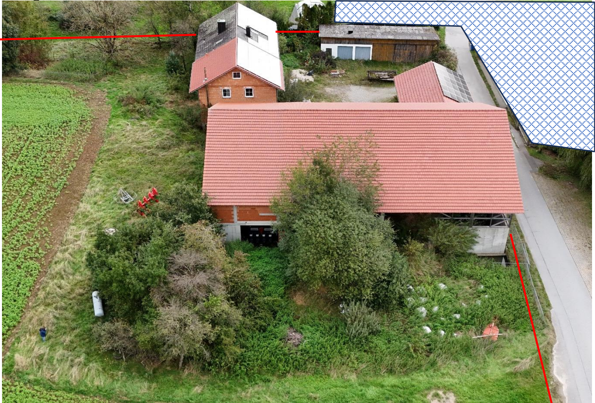
Bild 1: Luftbildaufnahme vom 30.09.2024 für den mit Wohn- und Wirtschaftsgebäuden bebauten Hofstellenbereich im Südostteil von Flurstück 2542, Blick von Westen nach Osten. Im Vordergrund die zweigeschossige Maschinenhalle mit der in südlicher (rechts) anschließenden Bergehalle, links dahinter das Wohnhaus, rechts dahinter die Doppelgarage mit Unterstand und ganz hinten der Maschinenschuppen mit Doppelgarage und Werkraum. Rechts am Bildrand die unmittelbar südlich entlang verlaufende Gemeindeverbindungsstraße. Die roten Linien markieren ungefähr den Verlauf der Grundstücksgrenzen.
