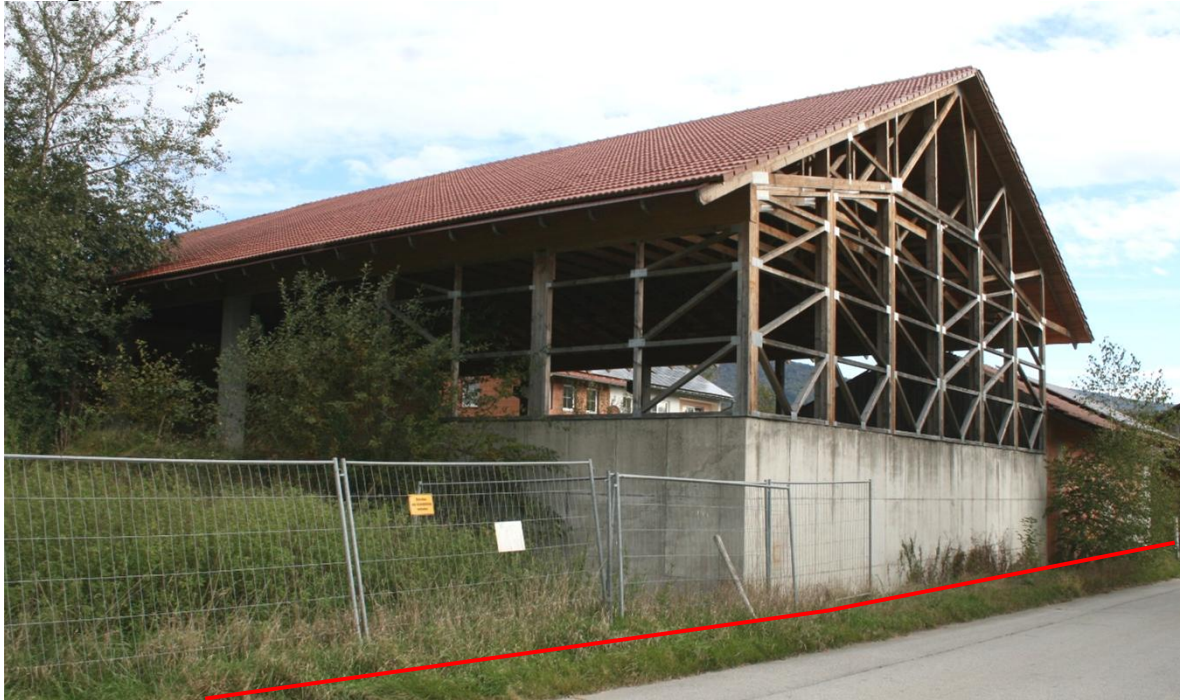
Bild 15: Standort auf der Gemeindeverbindungsstraße, die direkt südlich am Hofstellenanwesen entlang verläuft, südwestlich des Hofstellenanwesens, Blickrichtung Nordosten. Im Bild die West- und Südseite der noch nicht fertig gestellten Bergehalle. Es fehlen noch die Wandbekleidung, die Regenrinnen und die äußere Einfriedung (Fundamente an der West- und Südseite liegen teilweise noch offen) und auch der Ausbauzustand der Halle im Innenbereich ist nicht bekannt, vermutlich liegt noch ein Naturboden vor.
