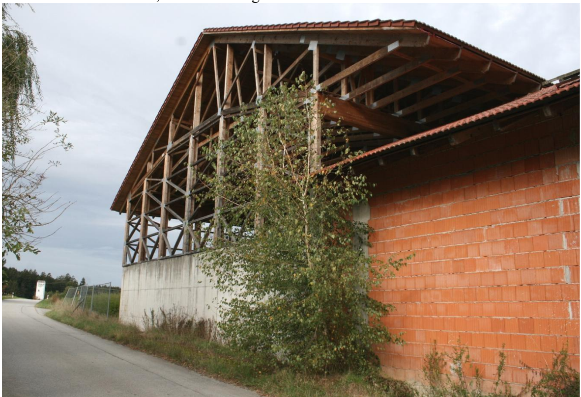
Bild 16: Standort auf der Gemeindeverbindungsstraße, die direkt südlich am Hofstellenanwesen entlang verläuft, südlich des Hofstellenanwesens, Blickrichtung Nordwesten. Im Bild die Südseite der noch nicht fertig gestellten Bergehalle mit der Betonwand und der aufliegenden Holzständerkonstruktion. Zwischen der Straße und den anschließenden Gebäuden auf der Hofstelle befindet sich ein asphaltierter Gehweg, der allerdings hier als solcher nicht zu erkennen ist, weil er komplett mit Gras überwuchert ist.
