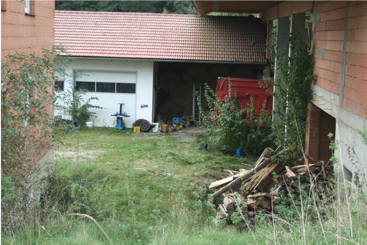
Bild 13: Standort dito. Bild 12; im nördlichen Bereich des Hofstellenanwesens, Blickrichtung Süden. Im Hintergrund nochmals die Nordseite des ca. 2010 errichteten Gebäudekomplexes aus Doppelgarage (links) und offenem Unterstand (rechts). Rechts im Vordergrund die Ostseite der zweigeschossigen Maschinenhalle mit dem offenem Einfahrtbereich im Untergeschoss und nach hinten anschließend die Ostseite der offenen Bergehalle (Betonssäulen auf Punktfundamenten und aufliegenden Leimbinder sowie Nagelbinder-Dachstuhl und ca. 3,00 m breites Vordach an der Ostseite.
