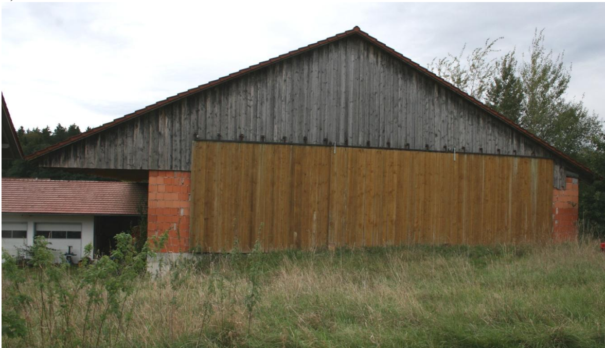
Bild 14: Standort im nördlichen Bereich des Hofstellenanwesens, Blickrichtung Süden. Im Bild die Nordseite der zweigeschossigen Maschinenhalle mit den drei Holzschiebetoren an der Nordseite des Obergeschosses. Laut den Bauplanunterlagen ist zum Obergeschoss hin eine Stahlbetondecke eingezogen, sodass das Obergeschoss auch als Unterstand für große bzw. schwere Schlepper und Arbeitsmaschinen genutzt werden kann. An der Ostseite (Hofinnenraum) befindet sich ein rund 3,00 m breites Vordach. Die Wände im Außenbereich sind noch unverputzt und der Ausbauzustand im Innern ist nicht bekannt.
