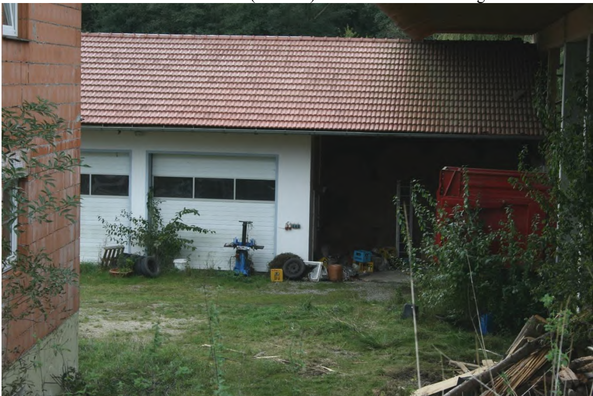
Bild 12: Standort im nördlichen Bereich des Hofstellenanwesens Bärnöd 10 in Grattersdorf, Blickrichtung Süden. Im Hintergrund die Nordseite des ca. 2010 errichteten Gebäudekomplexes aus Doppelgarage (linker Gebäudeteil mit den zwei Einfahrtstoren und vermutlich zwei Geschossflächen) und dem offenen Unterstand (rechter Gebäudeteil). Das gesamte Gebäude ist in massiver Bauweise errichtet worden. Links am Bildrand im Vordergrund die Westseite des Wohnhauses und rechts am Bildrand die Ostseite der offenen Bergehalle.
