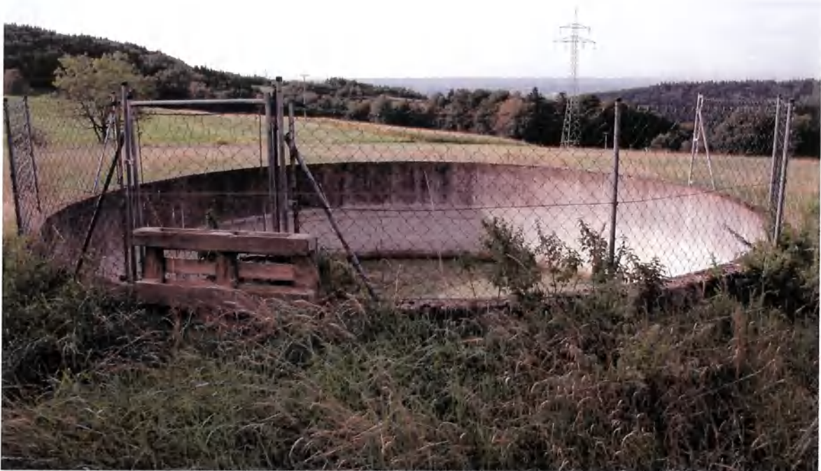
Bild 11: Im Bild die in monolithischer Bauweise errichtete Güllegrube, die sich im Nordostteil von Flurstück 888 befindet. Der nördliche Teil der Güllegrube ist mit einem Maschendrahtzaun umgeben und dort ist eine schwenkbare Tür eingelassen. Vom Stall auf dem Hofstellengrundstück mit der Fl.Nr. 806 (= Bewertungsgrundstück) führt eine unterirdische Leitung zu bzw. in die Güllegrube. Die betonierte Güllegrube weist einen Innendurchmesser von ca. 8,00 m bzw. einen Außendurchmesser von rund 8,40 m auf.
