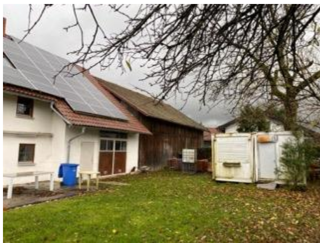
Südwestansicht Garage mit Holzlager und Scheune sowie Container
