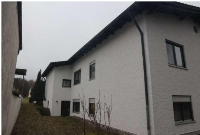
Nordostfassade des Gebäudes
