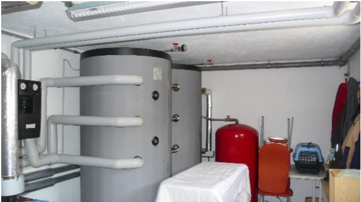
Abbildung 24 Bestand KG Pufferspeicher
