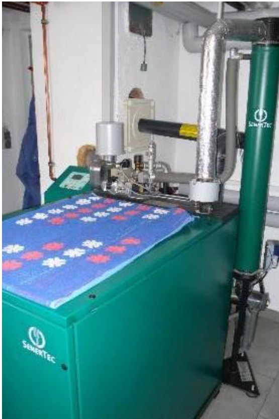
Abbildung 23 Bestand KG BHKW
