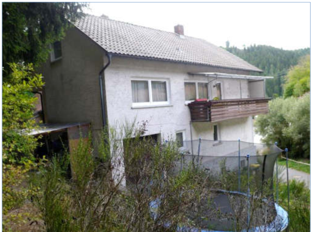
Bild 4 Pos. 01 Wohnhaus, Ost- und Nordseite
