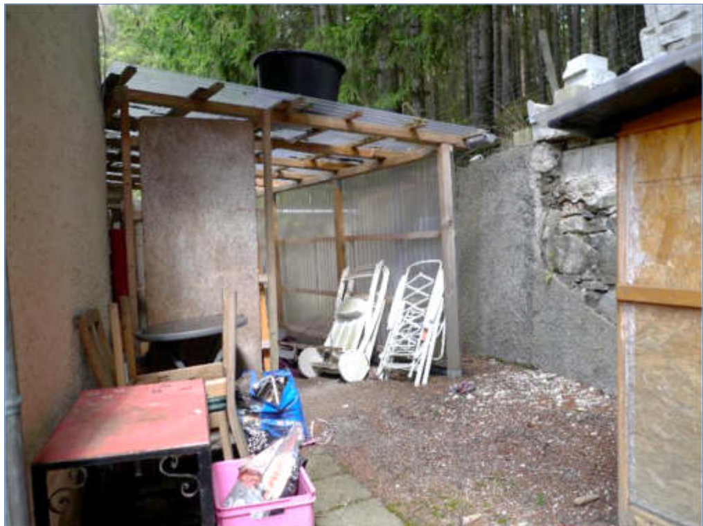
Bild 6 BBT Überdachung und Stützmauer Ostseite
