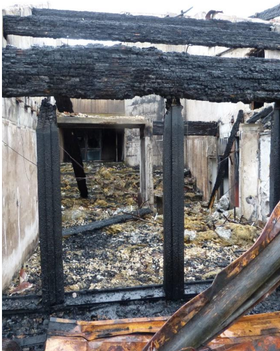
Ehemaliges Hotelgebäude, Innenaufnahme
