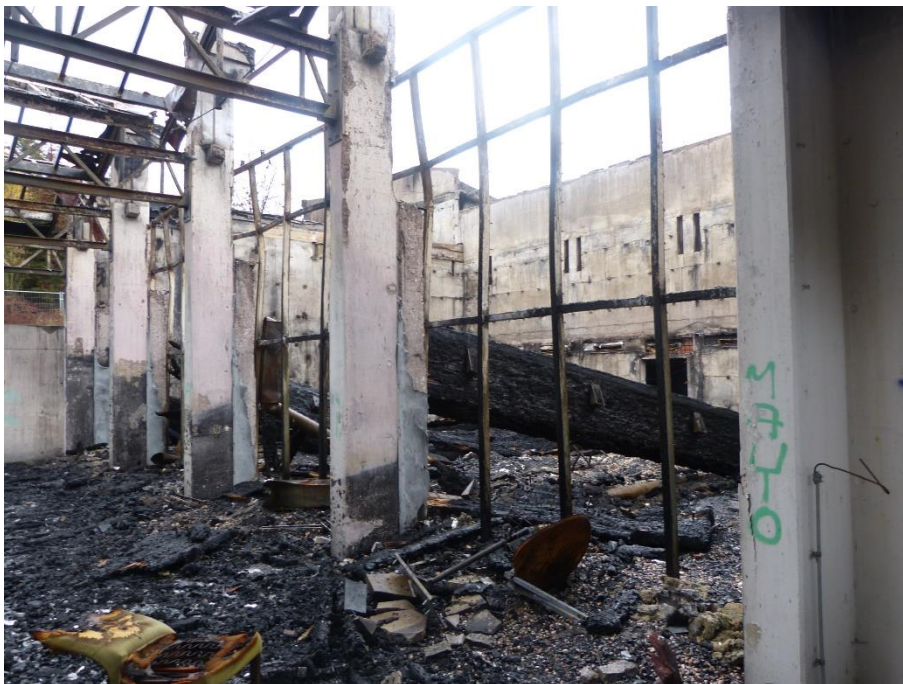
Ehemaliges Hotelgebäude, Innenaufnahme
