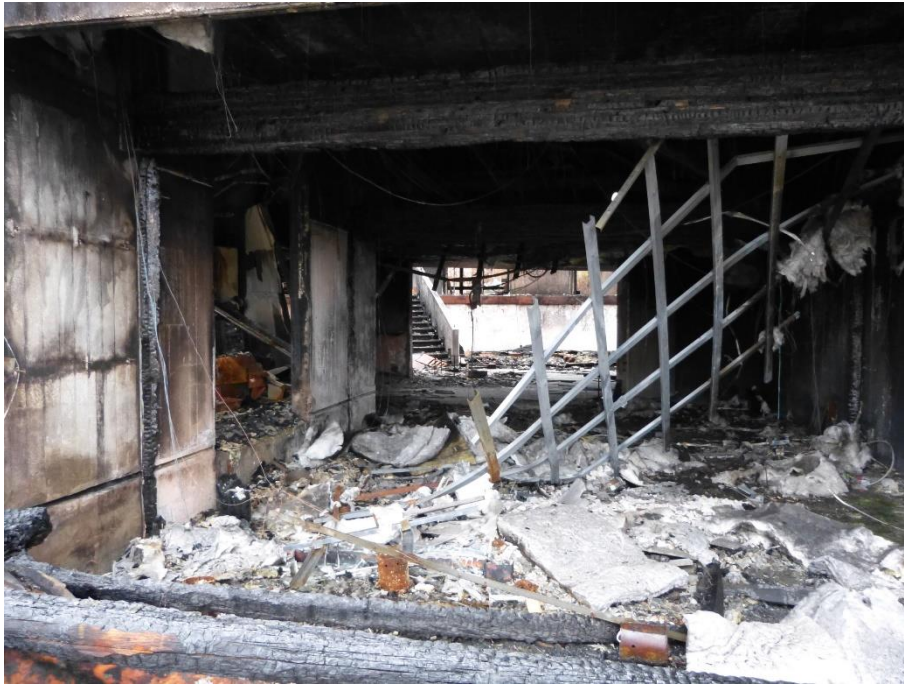
Ehemaliges Hotelgebäude, Innenaufnahme
