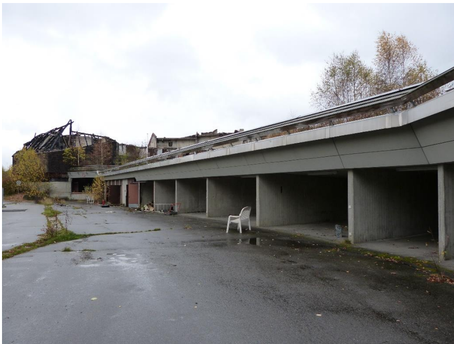
Garagen- und Funktionsgebäude
