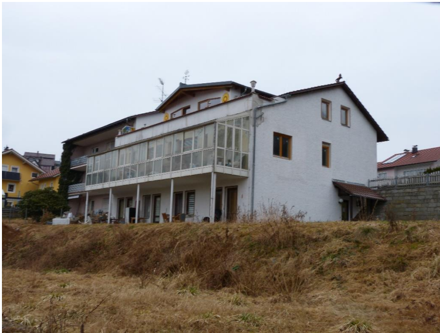
Wohnungseigentum Nr. 1, Ansicht von Südwesten
