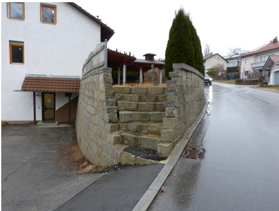
Wohnungseigentum Nr. 1, Teilansicht Stützmauer von Süden
