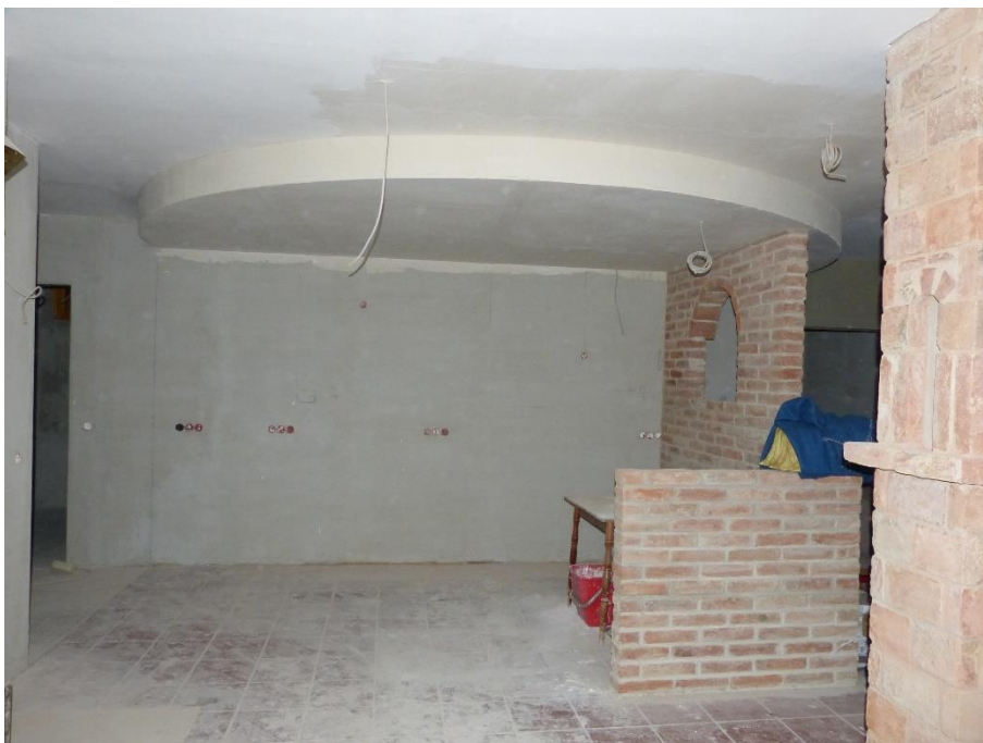
Wohnungseigentum Nr. 1, Innenaufnahme Kochbereich (im Umbau) im Erdgeschoss
