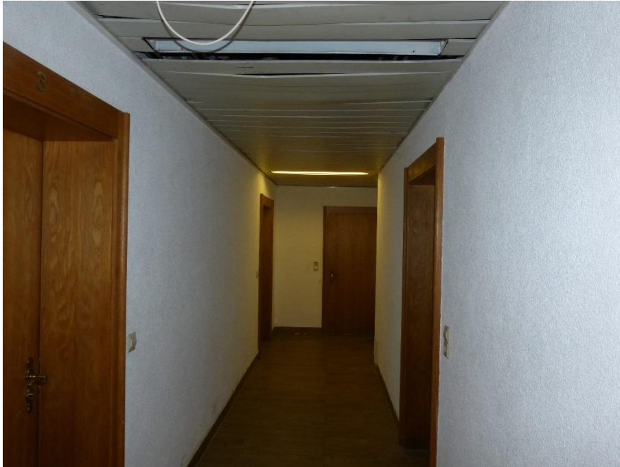
Wohnungseigentum Nr. 1, Innenaufnahme Flur im Untergeschoss
