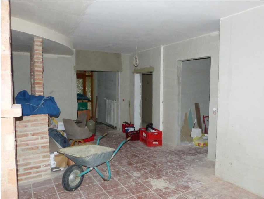
Wohnungseigentum Nr. 1, Innenaufnahme Wohnbereich (im Umbau) im Erdgeschoss
